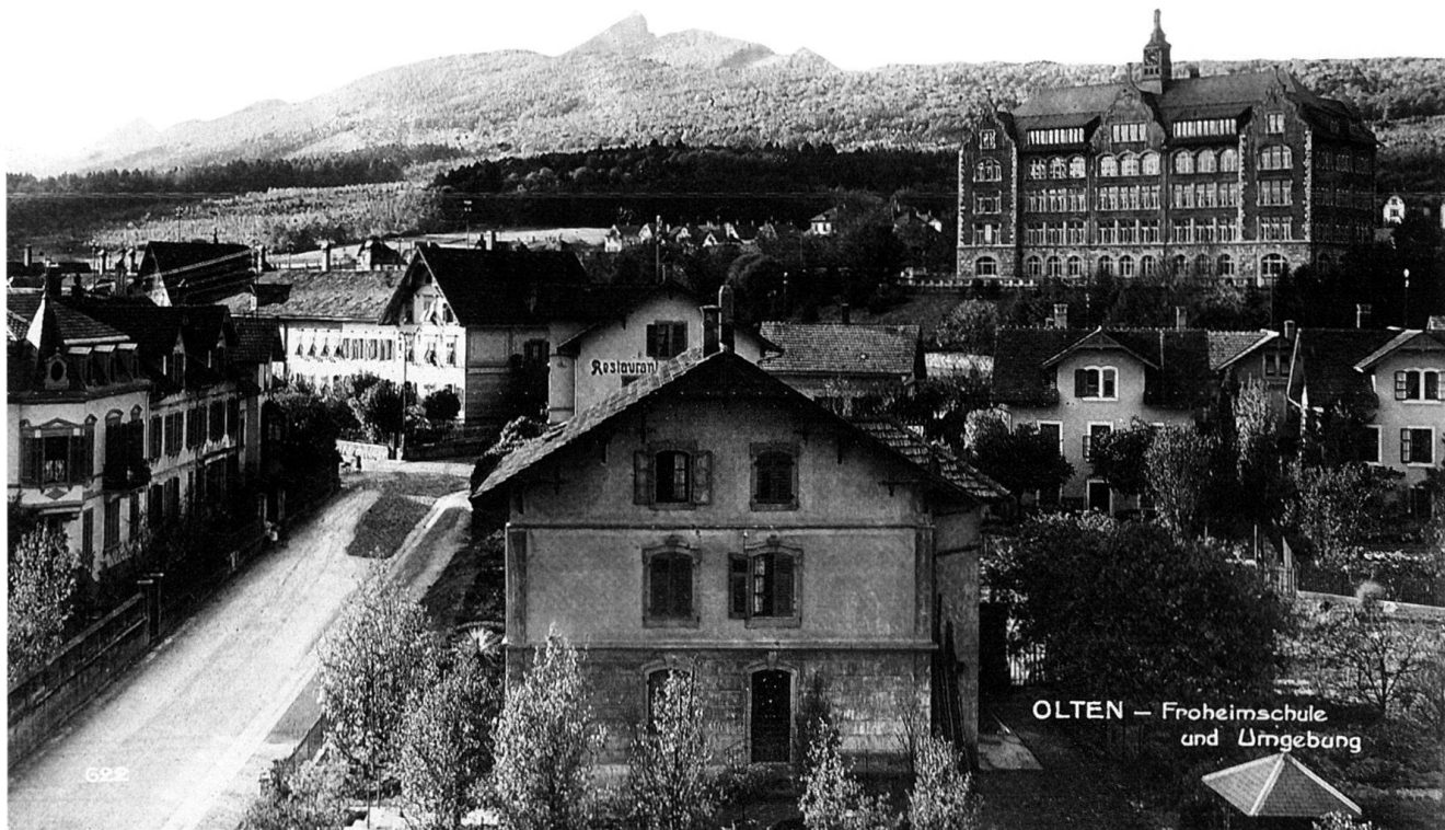
Abb. 36 Schulhaus Frohheim, erbaut 1898–1900. Links aussen das Haus des «Cementiers» Pietro Turuvani (Ziegelfeldstrasse 5). Postkarte.
