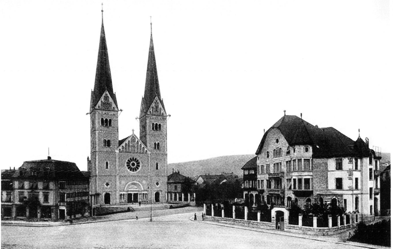
Abb. 35 Die römisch-katholische Martinskirche, erbaut 1908–1910, mit Doppelturmfassade gegen die Ringstrasse . Rechts das Arzthaus Sonneck (Nr. 30). Postkarte.
