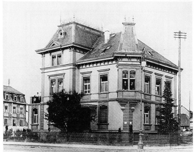
Abb. 14 Wohnhaus mit Büro des Bauunternehmers und Zementwarenfabrikanten Constantin (I.) von Arx (Solothurnerstrasse 14), erbaut 1889.
