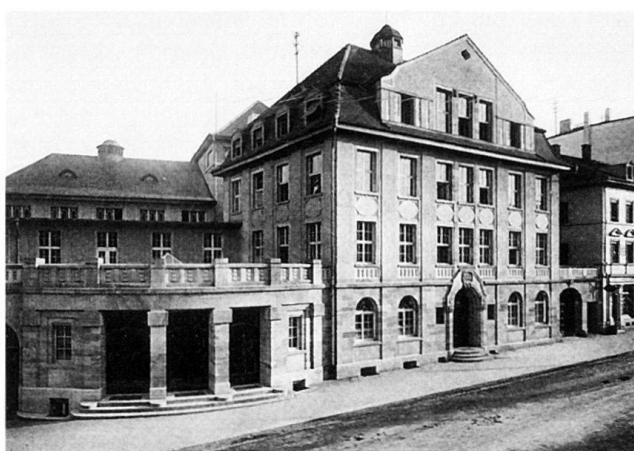
Abb. 43 Stadthaus, erbaut 1908–1910 von der Bürgermeinde für sich selbst und für die Einwohnergemeinde. Links der Eingang zum rückwärtig erstellten Stadttheater.
