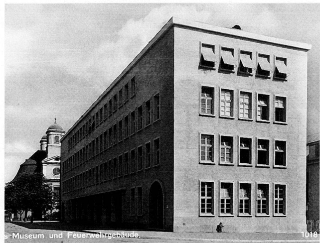
Abb. 45 Fragment der geplanten Hübeli-Überbauung: Feuerwehrgebäude mit Schul- und Museumsräumen, erbaut 1930–31.
