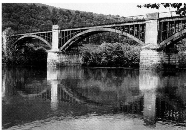
Abb. 22 Eisenbahnbrücke der alten Hauensteinlinie, erbaut 1857–1858.
