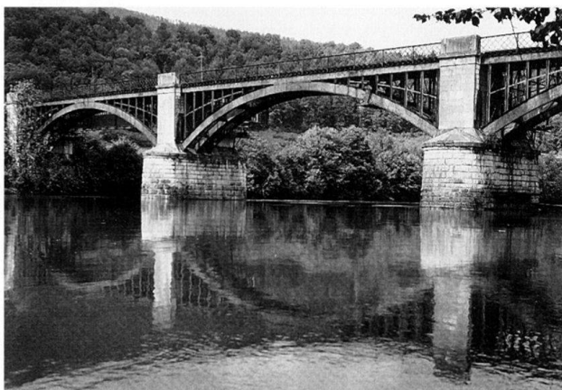
Abb. 22 Eisenbahnbrücke der alten Hauensteinlinie, erbaut 1857–1858.
