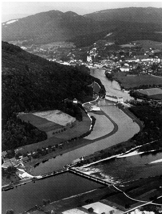
Abb. 37 Flusskraftwerk Ruppoldingen der Aktiengesellschaft Elektrizitätswerk Olten-Aarburg, erbaut 1894–1896: Kanal mit Maschinenhaus.
