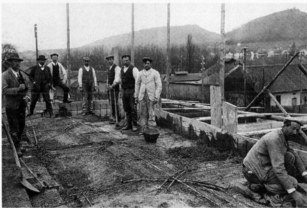
Abb. 6 Das Bifang-Schulhaus im Bau (1908–1910).
