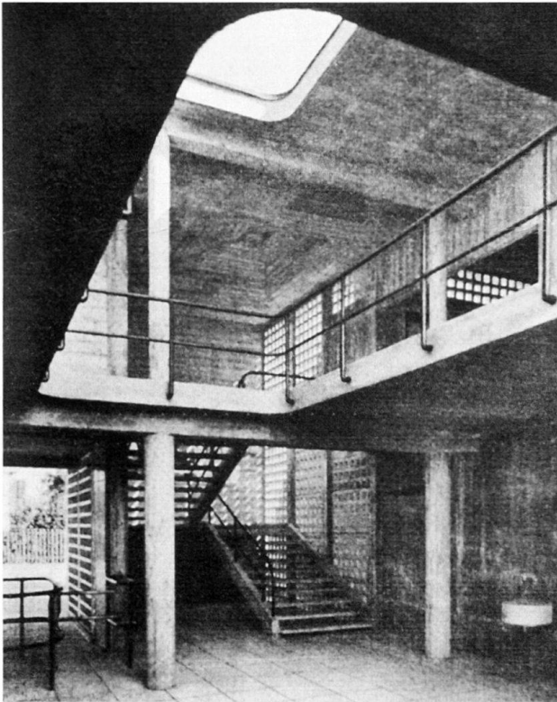
Abb. 46 Badeanlage an der Aare, erbaut 1936–1938. Eingangshalle des Garderobetrakts.
