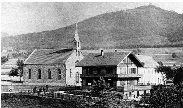
Abb. 25 Die erste reformierte Kirche, erbaut 1859–60 auf Initiative Niklaus Riggerbachs. Rechts dessen Wohnhaus, ein 1858 erstelltes Chalet.
