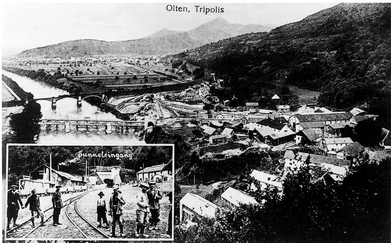
Abb. 4 Die Barackenstadt «Tripolis» vor dem Tunneleingang der 1912–1916 erstellten Hauenstein-Basislinie. Postkarte.
