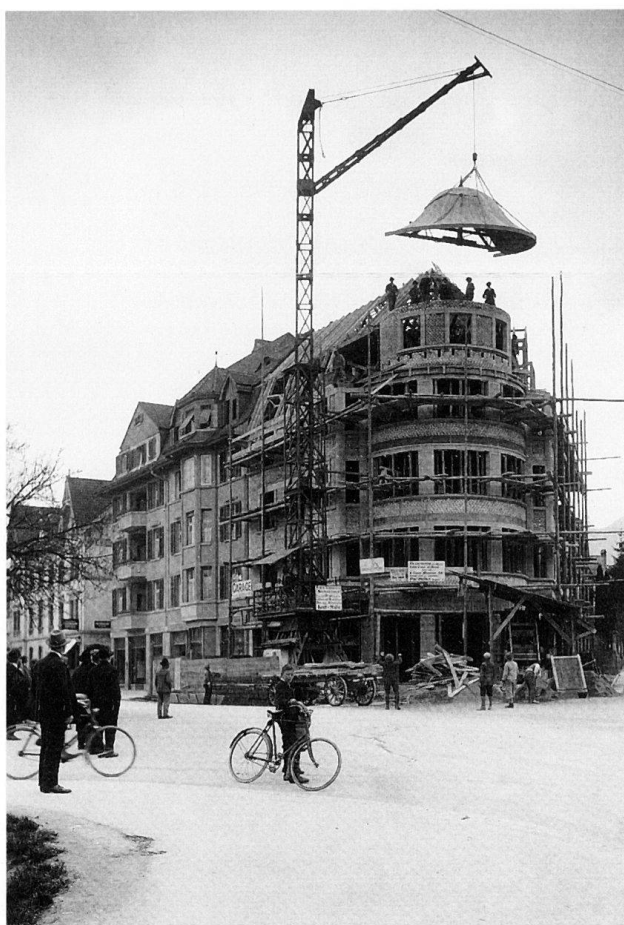
Abb. 8 Das Geschäftshaus Ziegelfeldstrasse 1 (in der Gabelung zur Ringstrasse) im Bau, um 1926.
