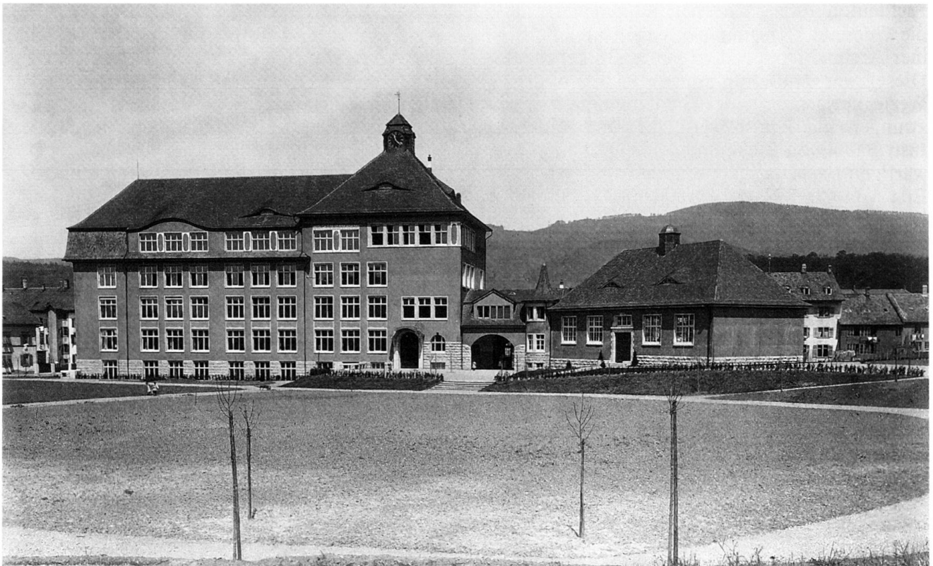
Abb. 41 Schulhaus im Bifang, erbaut 1908–1910. Rückfassade mit Spielwiese.
