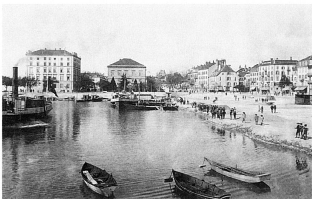
Fig. 48 Suite à la première correction des eaux du Jura, dragage du port et mesures provisoires à répétition débouchent sur le comblement de la partie nord, vers 1887 (2.4.1). Photographie coll. Bickel (MAHN).
