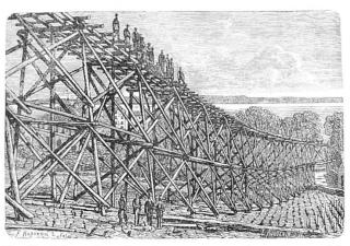
Fig. 49 Adepte du système des vases communicants, les autorités font acheminer les matériaux provenant de l'arasement du Crêt-Taconnet jusqu'au bord du lac par un ingénieux système de plan incliné (2.4.1). Tiré de: Mbx 1880, p. 39.
