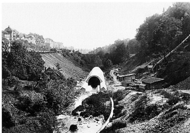
Fig. 28 La présence du Seyon demeure un handicap pour la ville de Neuchâtel en pleine extension, jusqu'à sa couverture presque complète en 1928–1937 (2.2.2). Photographie Corbellari (AVN).
