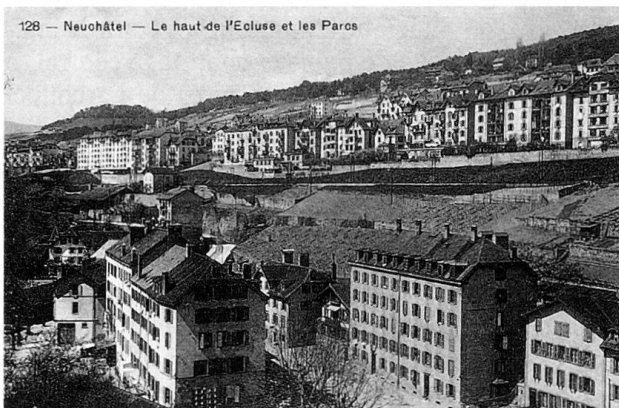
Fig. 85 Quartier des Parcs et de l'Ecluse, exemple d'habitat ouvrier collectif (2.6.1). Carte postale (AVN).
