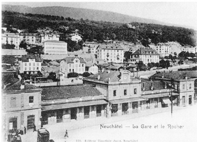
Fig. 21 Gare de Neuchâtel (2.5.3). Au grand dam des exploitants de calcaire neuchâtelois, le deuxième bâtiment des voyageurs est construit en molasse de Fribourg, 1880–1883. Carte postale (MAHN).
