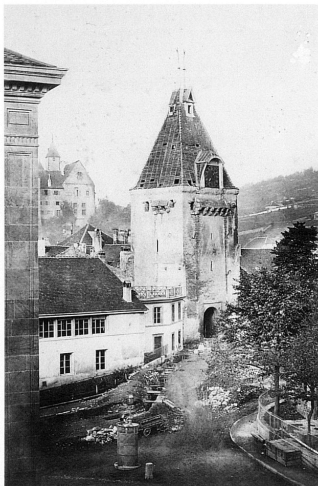
Fig. 42 Dernier vestige de l'enceinte de la ville, la tour des Chavannes succombe aux progrès de l'hygiène et de la salubrité en 1867 (2.3.2 et 2.7). Photographie Bruder frères (MAHN).
