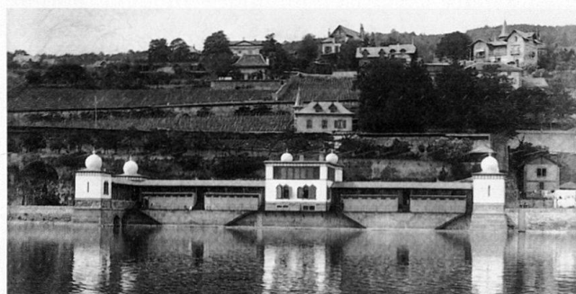
Fig. 11 Nouveaux bains des dames à proximité de l'Evole. En 1890, les autorités achèvent l'aménagement des nouvelles rives par six établissements de bains du dernier cri (2.4.2). Photographie V. Attinger.
