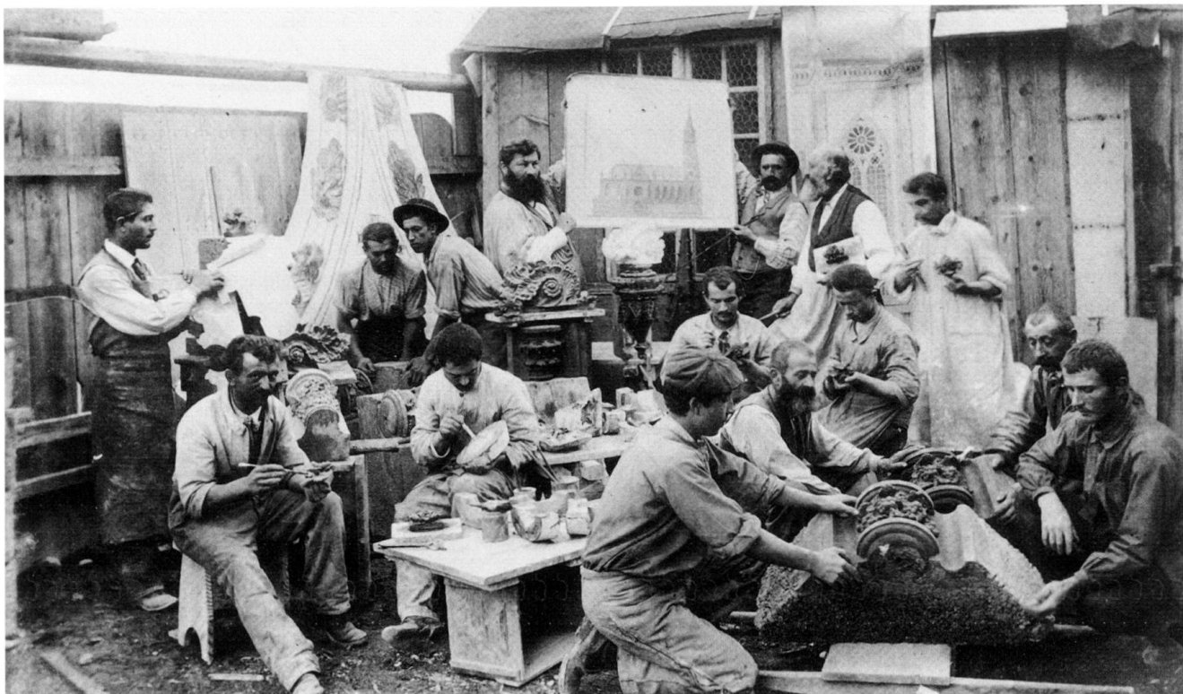
Fig. 15 A l'image des bâtisseurs de cathédrales, les ouvriers du chantier de l'Eglise rouge, 1897–1906 (2.6.2). Photographie anonyme (Paroisse catholique).
