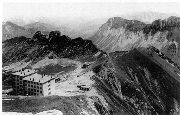
Fig. 8 L'Hôtel des Rochers de Naye au terminus du chemin de fer du Glion-Naye en 1893.
