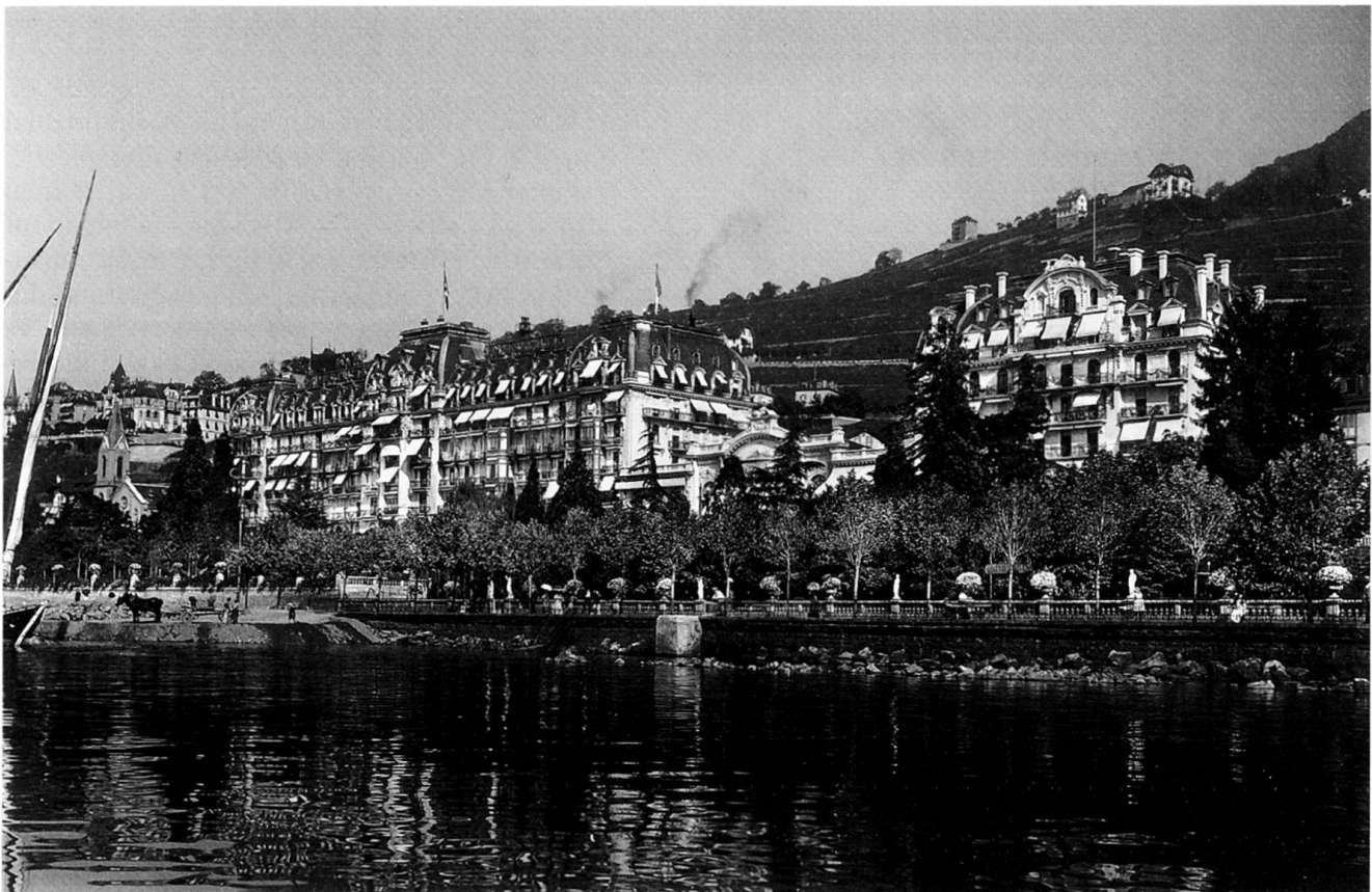
Fig. 46 Le mur et la rangée d'arbres rectiligne du quai Edouard Jaccoud vers 1908; au droit du Montreux-Palace qui vient d'être achevé, on distingue le remblai établi aux frais de l'hôtel pour lui permettre de créer un terrain de tennis.
