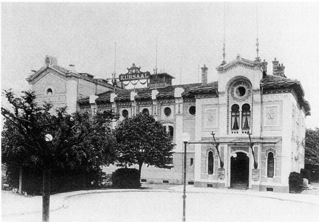
Fig. 19 La façade d'entrée du premier Kursaal ouvert en 1881.
