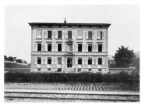
206/1. **No 5** Buffet de la gare, 1911 (aut.), Villard pour SI de Glion. Vaste chalet en maçonnerie dont la terrasse et le perron sont couverts d'un large auvent sur poteaux de bois. L'int. du café comporte encore les stucs et boiseries d'origine. Planchers en béton armé syst. Hennebique. Menuis. complètes Held. Source: JTH. Bibl. 1) *BA* 15 (1912), No 173, p. 160.
