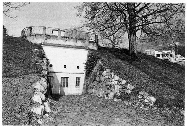
Abb.17 Schwyz, Hauptfleck. Reservoir auf der Mangelegg (Obermatt) nach Plänen von Geometer Koch aus Zug, erbaut 1891. Bauzustand und Fotografie 1987.
