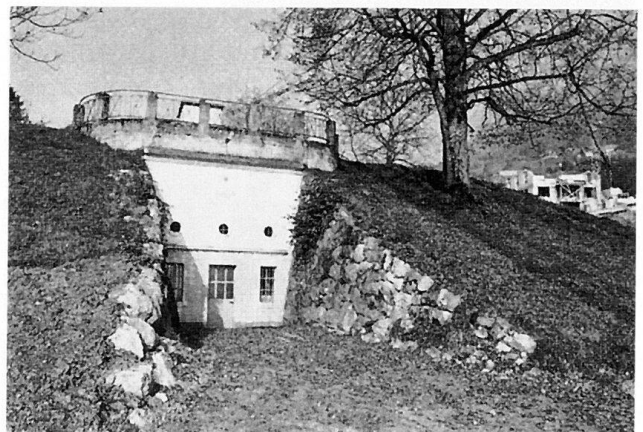
Abb.17 Schwyz, Hauptfleck. Reservoir auf der Mangelegg (Obermatt) nach Plänen von Geometer Koch aus Zug, erbaut 1891. Bauzustand und Fotografie 1987.
