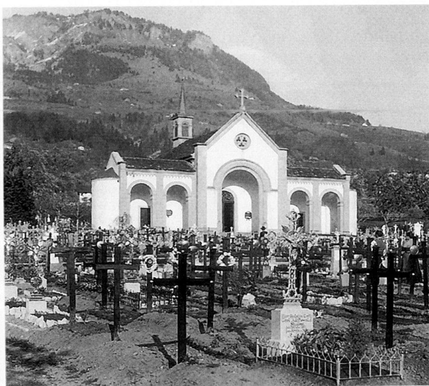
Abb. 15 Schwyz, Hauptfleck. Kapelle auf dem Friedhof, ausgeführt 1863. Architekt Ferdinand Stadler. Fotografie um 1890.
