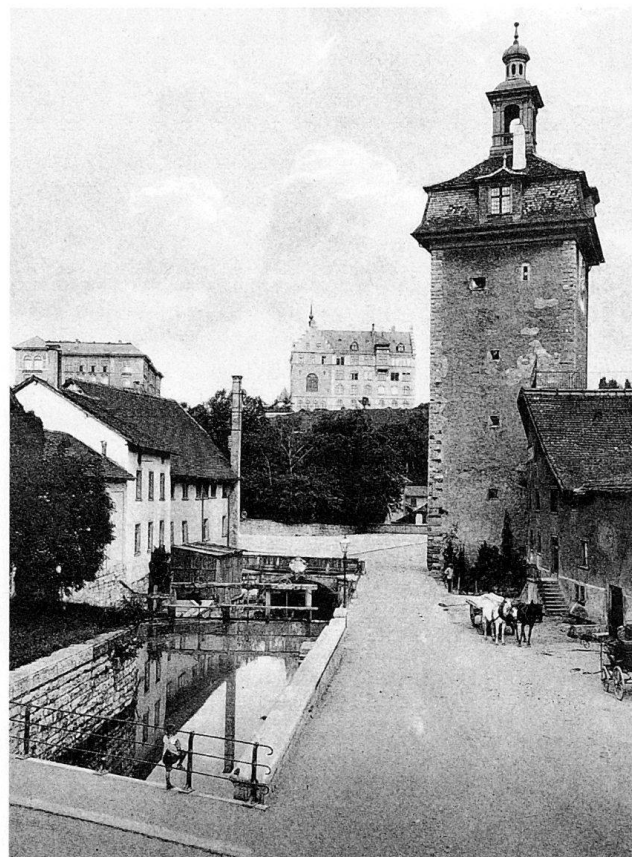
Abb. 50 Die Adlerstrasse und der Schwabentorturm. Ganz vorn die Bahnhofstrasse, 1894–1896 an dieser Stelle abgesenkt, um als Zugang zur neuen Adler-Unterführung zu dienen (vgl. Abb. 38). Links vom Turm der 1866/1868 erstellte Einlaufbogen zum Gerberbachkanal unter der Bachstrasse (vgl. Abb. 13). Hinten die beiden Schulpaläste auf dem Emmersberg: das 1892–1894 erstellte Elementarschulhaus (links) und die 1900–1902 erbaute Kantonsschule. Postkarte.
