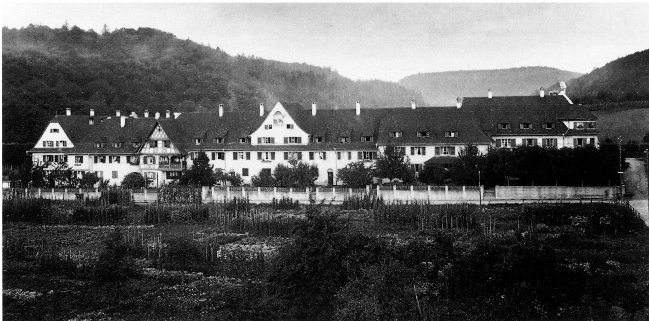
Abb. 60 Arbeiterkolonie an der Stahlwerkstrasse, erbaut 1910 von Curjel & Moser für die Baugesellschaft Breite AG (Tochtergesellschaft der Fischerschen Stahlwerke).
