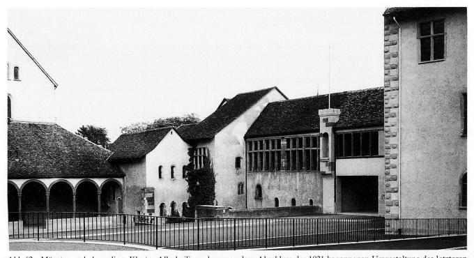
Abb.62 Münster und ehemaliges Kloster Allerheiligen, kurz vor dem Abschluss der 1921 begonnenen Umgestaltung des letzteren zum Museum. Rechts aussen die neue, in der Mitte die alte Abtei, dazwischen neuer, brückenartiger Verbindungstrakt, mit Durchfahrt der Klosterstrasse und Zugang zum Museum. Links aussen die neuromanische Münster-Vorhalle von 1857. Zwischen ihr und der Klosterbogen-Strasse (ganz vorn) dreifache Abstufung. Fotografie 1937.
