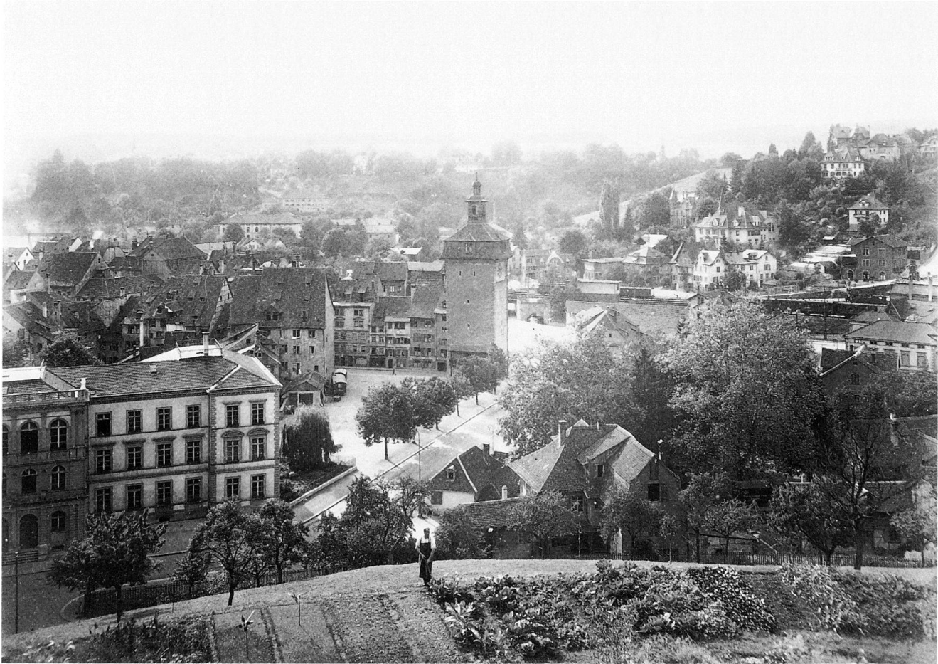
Abb. 38 Bachstrasse und Schwabentorareal von Osten. Fotografie von Carl Friedrich Heller (1874–1961), 1929. Über dem Gerberbach ist die Bachstrasse erstellt worden, an der Stelle der Gärten vor der Stadtmauer die Mädchenschule. Zwischen dieser und dem Turm der sogenannte Hirschenplatz, entstanden anstelle von Gärten und von abgebrochenen Häusern. Rechts vom Turm der Tunnel des Mühlentalerbachs unter dem Bahndamm, links davon (knapp sichtbar) die 1895 erstellte Adler-Unterführung.
