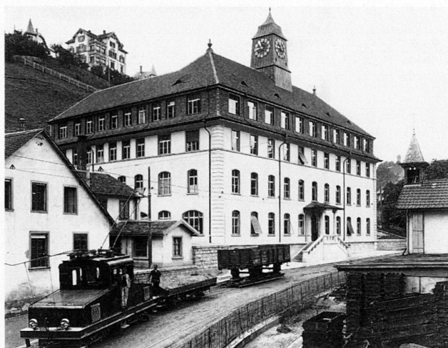
Abb.6 Das Verwaltungsgebäude der Stahlwerke +GF+, mit einem Zug der 1913 eröffneten Werkbahn. Zuhinterst ein «Rollschemel» mit einem Normalspur-Güterwagen. Foto Koch, 1912.
