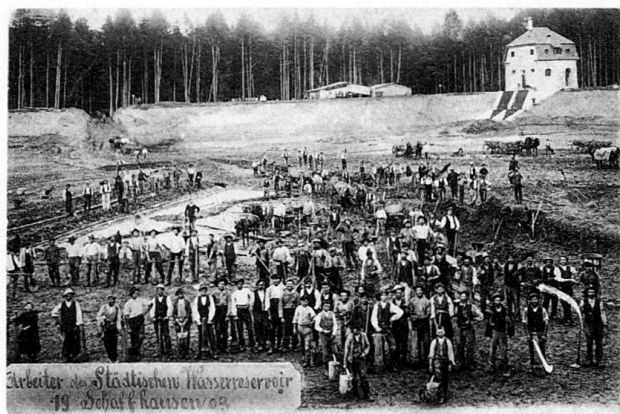
Abb. 16 Arbeiter beim Bau des Engweihers (Reservoir der Akkumulierungsanlage des Elektrizitätswerkes), 1909.
