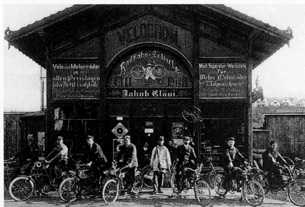
Abb.9 Radfahrer vor dem Garderoben- und Werkstattgebäude des 1898 eröffneten «Velodroms» auf dem «Rabenplatz».
