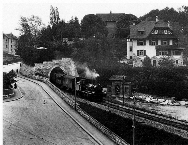
Abb.7 Die Nordeinfahrt des 1893–1895 für die Etwilerlinie erbauten Emmersbergtunnels. Rechts das Haus Pestalozzistrasse 15. Foto Koch, 1908.
