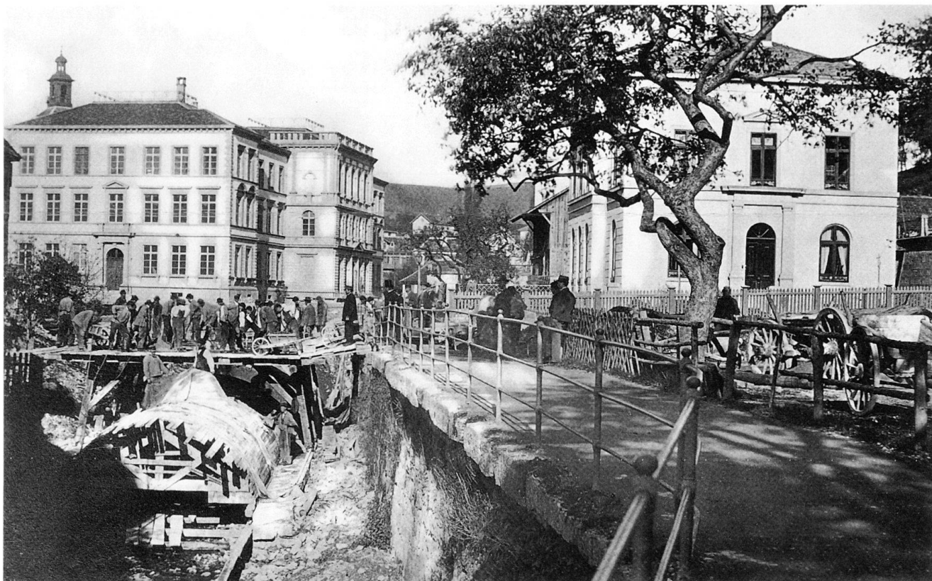
Abb. 13 Aufnahme der Bachstrasse während der vierten Etappe der Gerberbach-Einwölbung (1871–1873). Links das Mädchen-schulhaus, rechts das Pfarrhaus, beide erbaut von Johann Gottfried Meyer. Foto Carl Koch.
