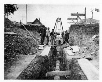
Abb.11 Arbeiter des Baugeschäftes Habicht beim Verlegen von Schwemmkanalisations-Rohren im Oststück der Speerstrasse, 1920/1921.
