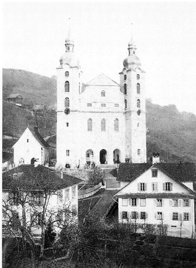
Abb. 4 Bergstrasse. Pfarrkirche St. Peter und Paul nach Vollendung der Doppelturmfront 1881. Fotografie um 1890.
