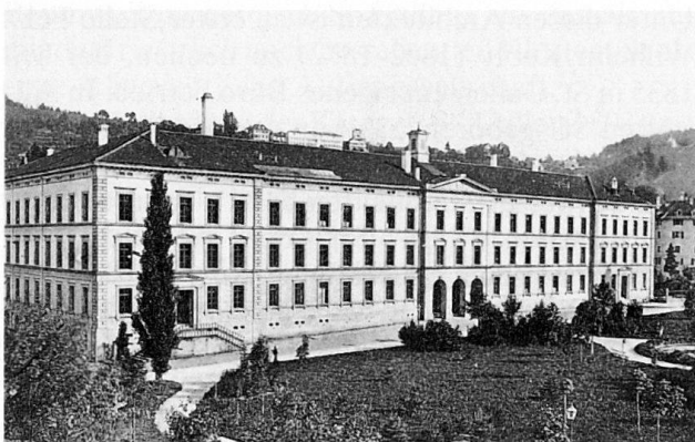
Abb. 39 St. Gallen. Bibliotheks- und Schulgebäude am Oberen Brühl (heute Kantonsschule). 1852–1855 erbaut von Felix Wilhelm Kubly. Fotografie J.U. Locher um 1865.
