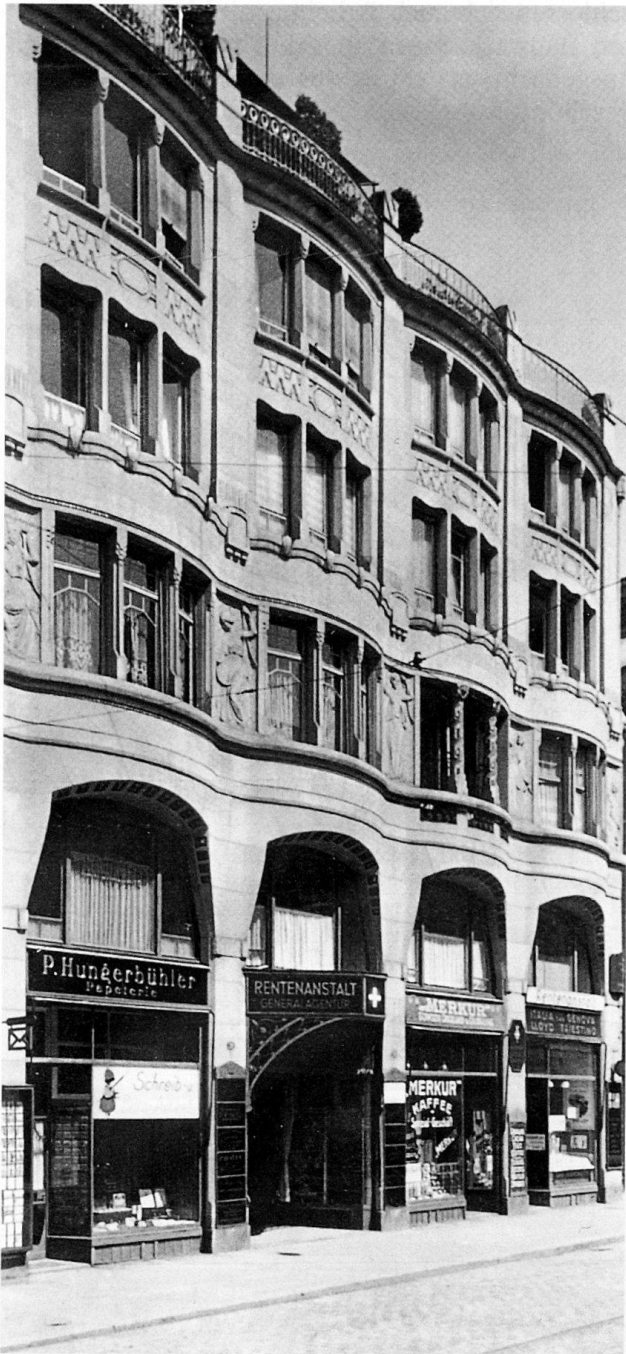
Abb. 55 St. Gallen. Stickereigeschäftshaus «Oceanic» an der St. Leonhard-Strasse. 1904–1906 erbaut von Pfleghard & Häfeli, Zürich. Art Nouveau-Wellenschlag in der Stickereimetropole. Fotografie um 1930.
