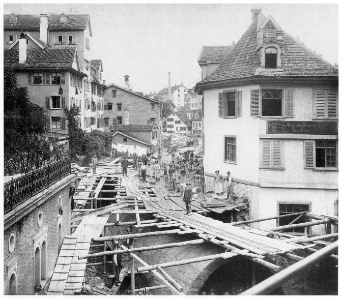
Abb. 82 St. Gallen. Linsebühl, Lämmlisbrunnen, Speicherstrasse. Die Überwölbung der Steinach zwischen Spisertor und Lämmlisbrunnen bildete das Trassee für die neue Lämmlisbrunnenstrasse. Fotografie 1893/94.
