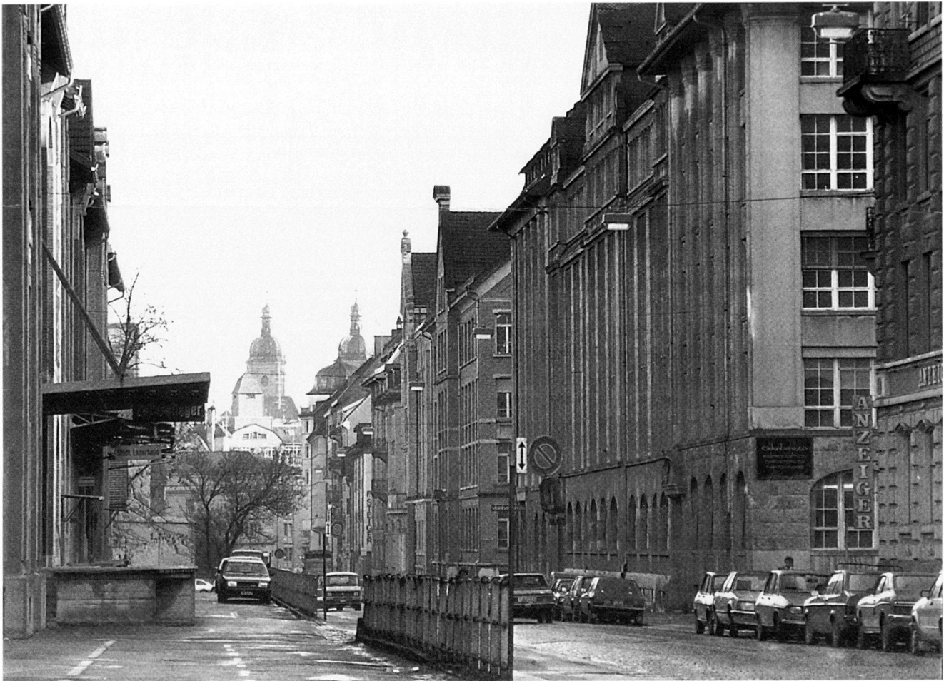
Abb. 61 St.Gallen. Davidstrasse im westlichen, bahnhofnahen Vorstadtbereich. Zentrum der Strickereigeschäftshäuser und Städtischen Lagerhäuser nach 1900. Fotografie 1982.
