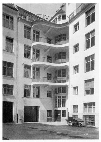
Abb. 59 und 60 St. Gallen. Stickereigeschäftshaus Labhard & Cie. Ecke Kornhausstrasse/Merkurstrasse. 1907/1908 erbaut von Pfleghard & Häfeli, Zürich. Eisenbetonbau mit Sandsteinverkleidung. Fassaden- und Hofansicht 1909.
