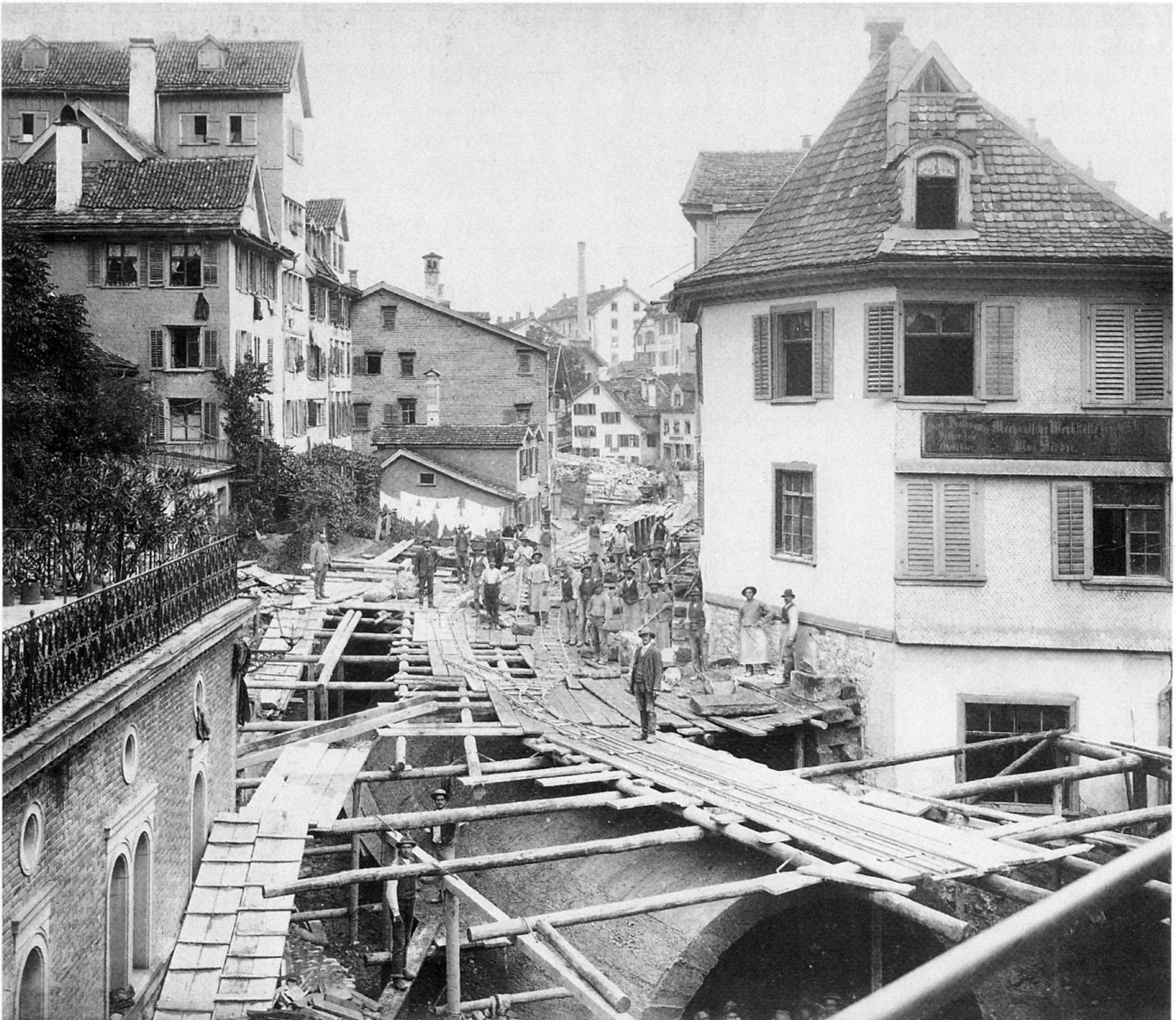
Abb. 82 St. Gallen. Linsebühl, Lämmlisbrunnen, Speicherstrasse. Die Überwölbung der Steinach zwischen Spisertor und Lämmlisbrunnen bildete das Trasse für die neue Lämmlisbrunnenstrasse. Fotografie 1893/94.
