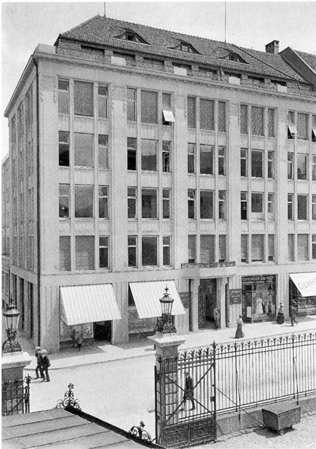
Abb. 59 und 60 St. Gallen. Stickereigeschäftshaus Labhard & Cie. Ecke Kornhausstrasse/Merkurstrasse. 1907/1908 erbaut von Pflegard & Häfeli, Zürich. Eisenbetonbau mit Sandsteinverkleidung. Fassaden- und Hofansicht 1909.
