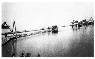
Abb. 11 St. Gallen. Bodenseewasserleitung 1896 zur Versorgung der zirka 260 m höher liegenden Stadt. Erstes Ausfahren der Seeleitung im «Riet» bei Rorschach am Bodensee am 16. August 1896.
