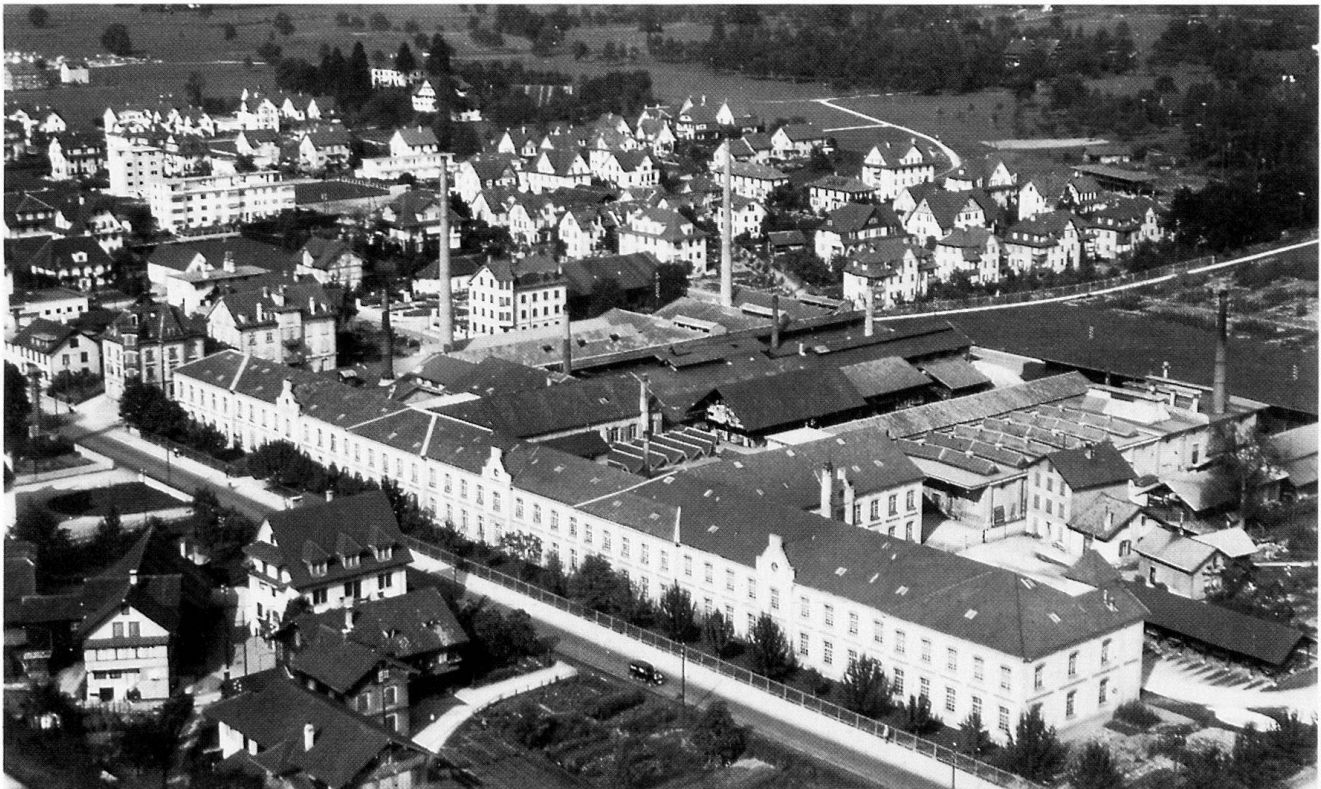
Abb. 22 Metallwarenfabrik Zug AG. Foto Swissair, 1922. Der längs der Baarerstrasse 1880/82 erstellte und 1912 um knapp 50 m nach Süden erweiterte Backsteinbau war über ein Jahrhundert das auch architektonisch bildhafte Zeugnis der Industriestadt Zug.
