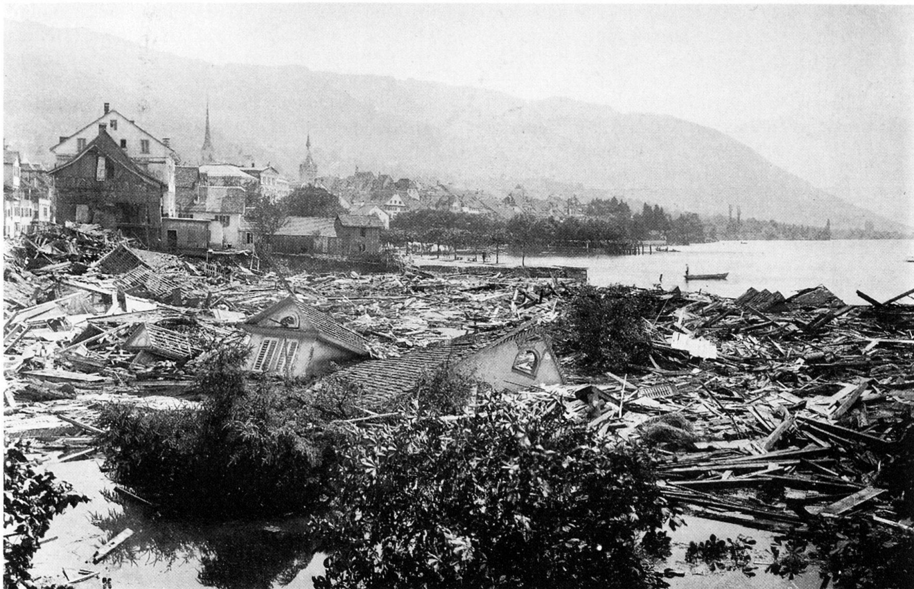
Abb. 16 Die Vorstadt am Tag nach dem Seeufereinbruch von der Passage zum Dampfschiffsteg aufgenommen. Lichtdruck von A. Synnberg in Luzern, 6. Juli 1887. Im Vordergrund sind Giebel und Dachkerker des zerstörten Hotels Zürcherhof noch zu erkennen.
