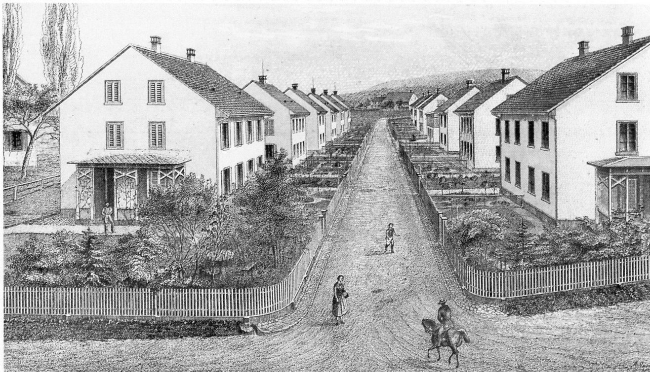
Abb. 40 Töss. Arbeiter-Modellsiedlung mit zweigeschossigen Doppel-Einfamilienhäusern für höhergestellte Facharbeiter, erbaut 1865–1876 von der Firma J. J. Rieter & Co. Lithographie der Anstalt Wurster, Randegger & Co.
