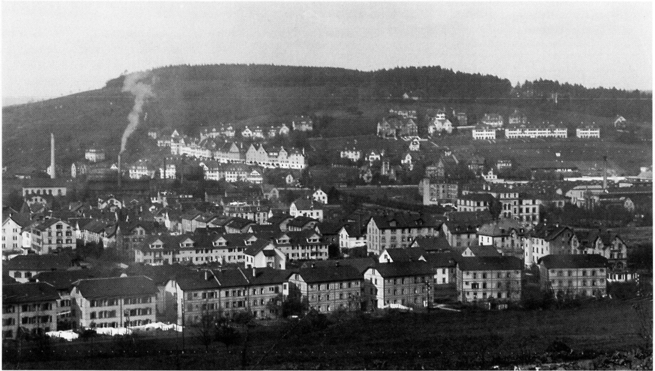
Abb. 42 Winterthur und Töss. Arbeiterhäuser der Gesellschaft für Erstellung billiger Wohnhäuser im Eichliacker, erbaut ab 1897. Im Hintergrund das Brühlbergquartier. Fotografie Guggenheim.
