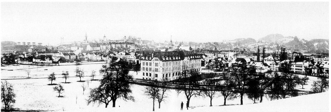
Abb. 56 Luzern. Maihofquartier mit Maihofschulhaus, 1905–1906 erbaut. Zeitgenössische Fotografie.
