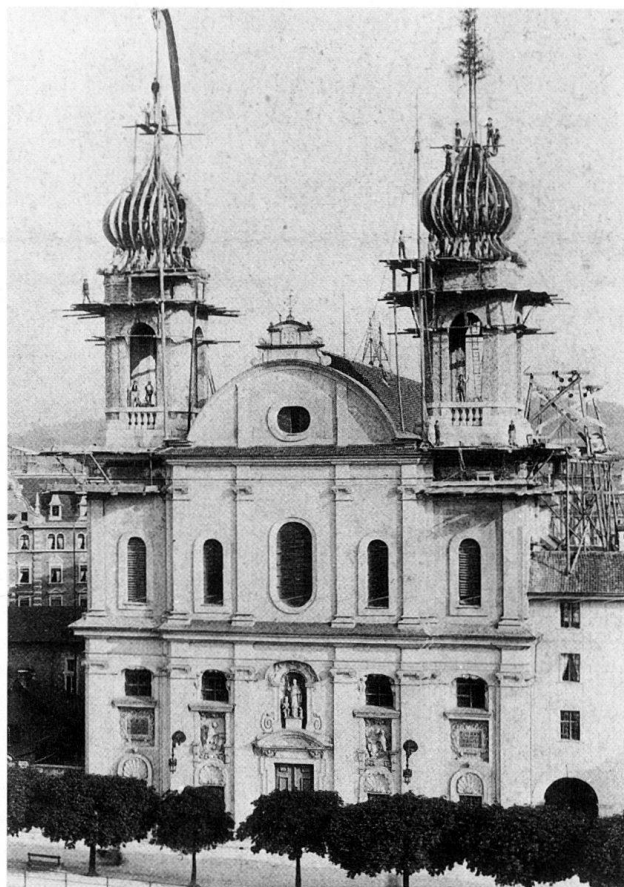
Abb. 46 Luzern. Jesuitenkirche während der Vollendung der Doppelturmfassade. Foto 1893.
