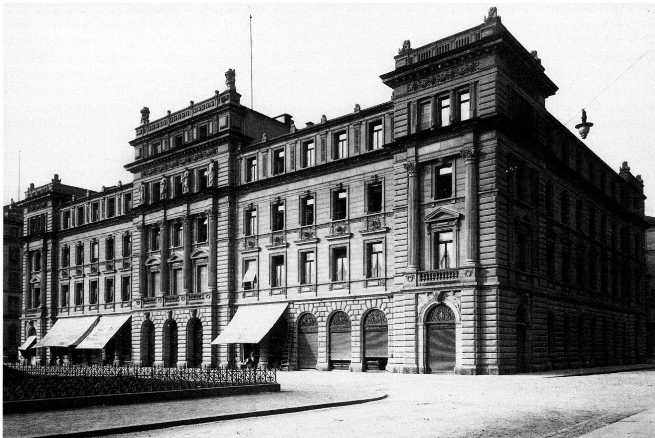
Abb. 38 Luzern. Verwaltungsgebäude der Gotthardbahn, erbaut 1886–1888. Zeitgenössische Fotografie.
