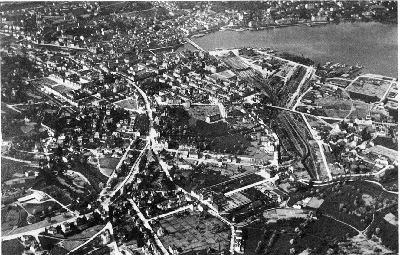
Abb. 69 Luzern, Flugaufnahme des Obergrunds von Süden. Foto um 1920.
