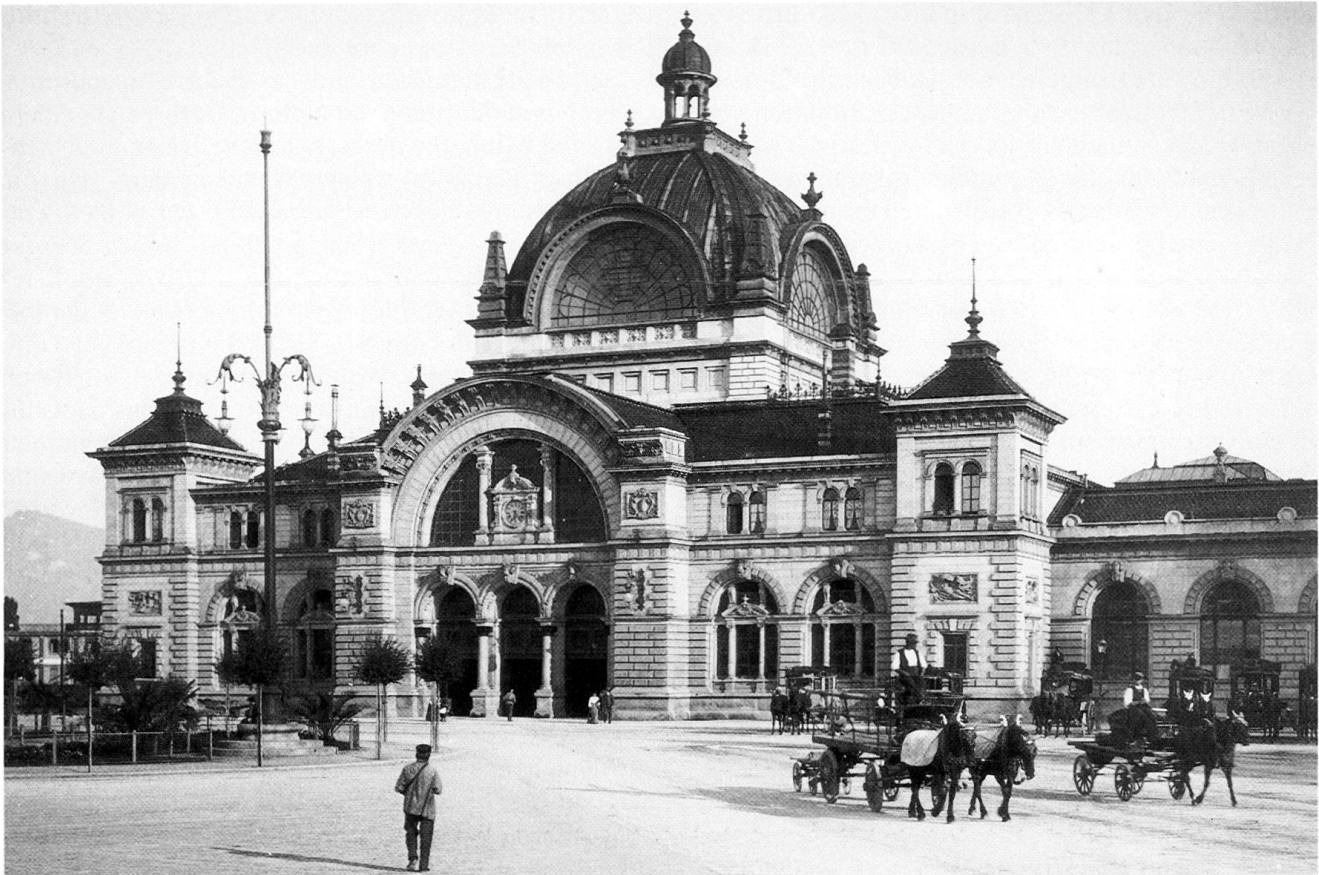
Abb. 39 Luzern, Bahnhof, erbaut 1894–1896. Zeitgenössische Fotografie.
