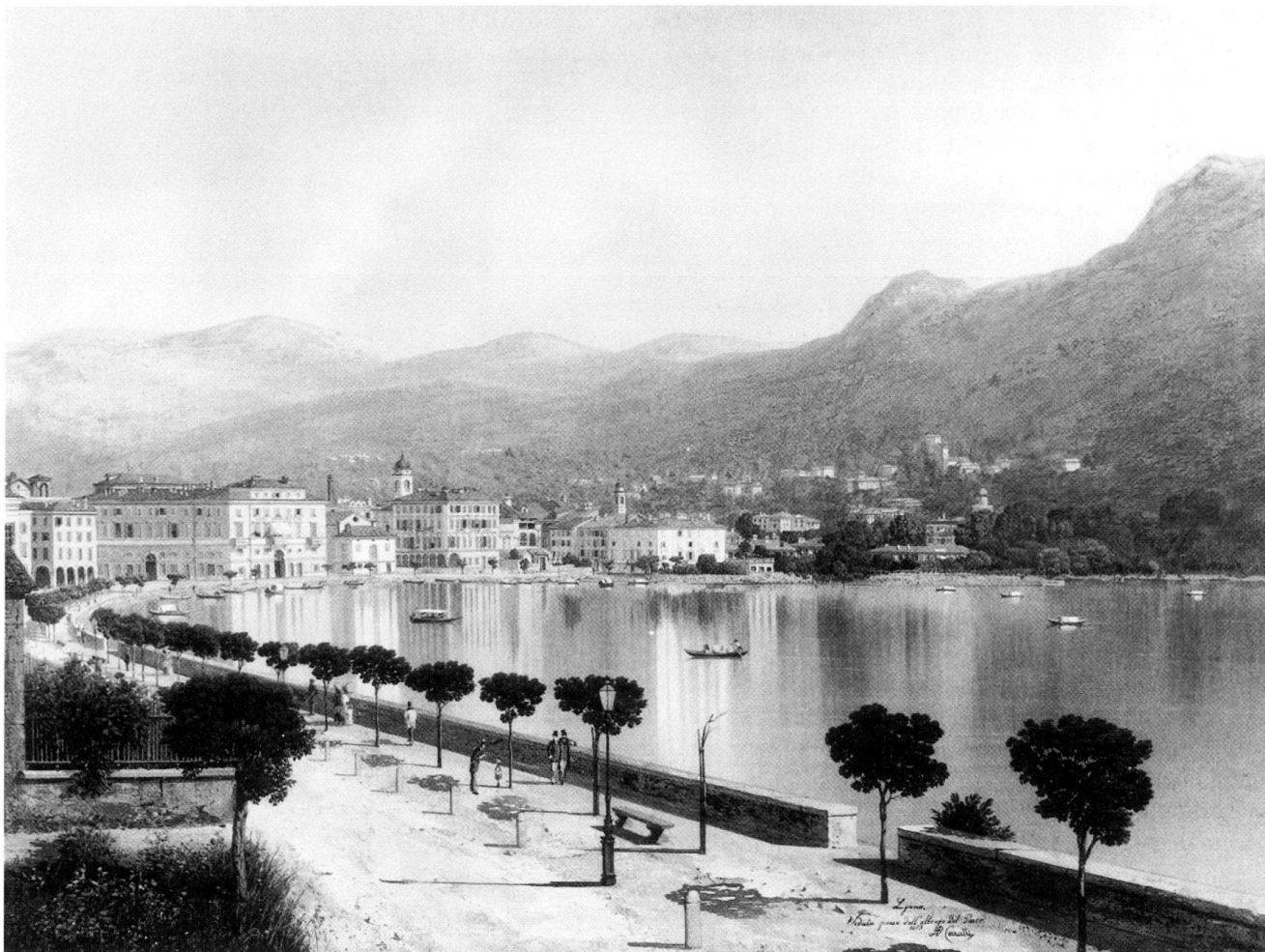
Ill. 35 Lugano. Riva Vincenzo Vela, il primo quai di Lugano costruito negli anni 1864–1867 su piani dell'ingegner Pasquale Lucchini. Guazzo di Caratti, 1883. Lugano, Ufficio tecnico.
