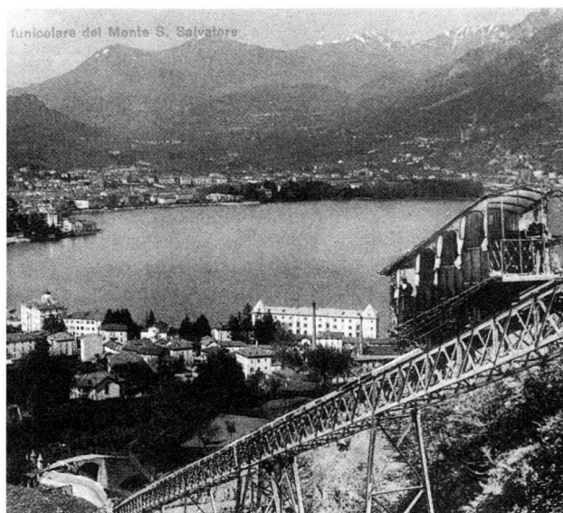
III. 7 Paradiso. Funicolare sul monte San Salvatore in esercizio dal 1890 – come la funicolare Lugano–Stazione, un'opera dell'impresa svizzero-tedesca Bucher-Durrer.
