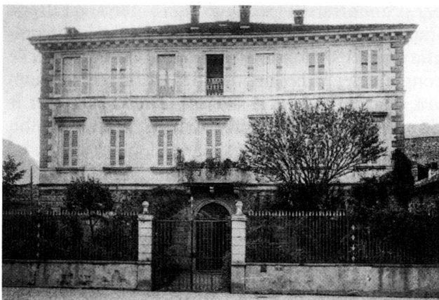
Ill. 25 La palazzina di Grato Albertolli edificata fra il 1815 e il 1818: un'opera del classicismo a Lugano.
