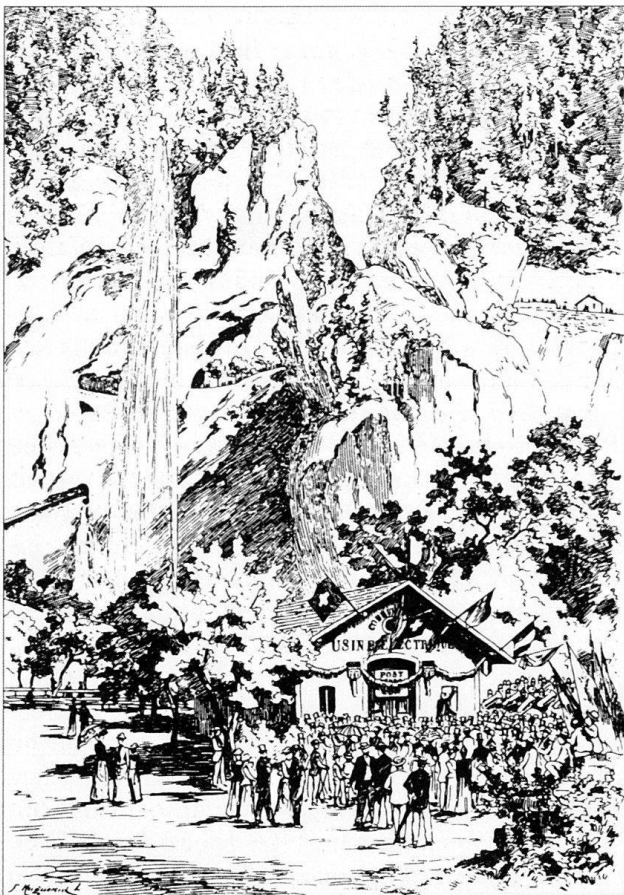
Fig. 33 Le Locle, inauguration de la centrale électrique La Rançonnière, 1890. Lithographie de Fritz Huguenin-Lassauguette. Le bâtiment des machines a été dessiné à l'envers.
