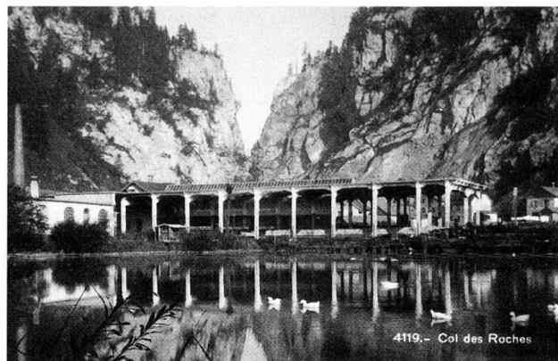
Fig. 35 Comme fig. 34. Toiture en béton armé de l'entrepôt de wagons, de 1909 par l'ingénieur Samuel de Mollins (Lausanne), représentant suisse de Hennebique. Au premier plan, réservoir de la centrale électrique (cf. fig. 33). Carte postale.
