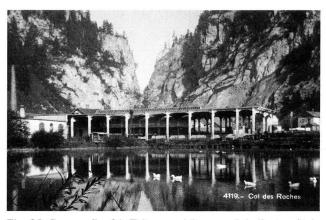
Fig. 35 Comme fig. 34. Toiture en béton armé de l'entrepôt de wagons, de 1909 par l'ingénieur Samuel de Mollins (Lausanne), représentant suisse de Hennebique. Au premier plan, réservoir de la centrale électrique (cf. fig. 33). Carte postale.
