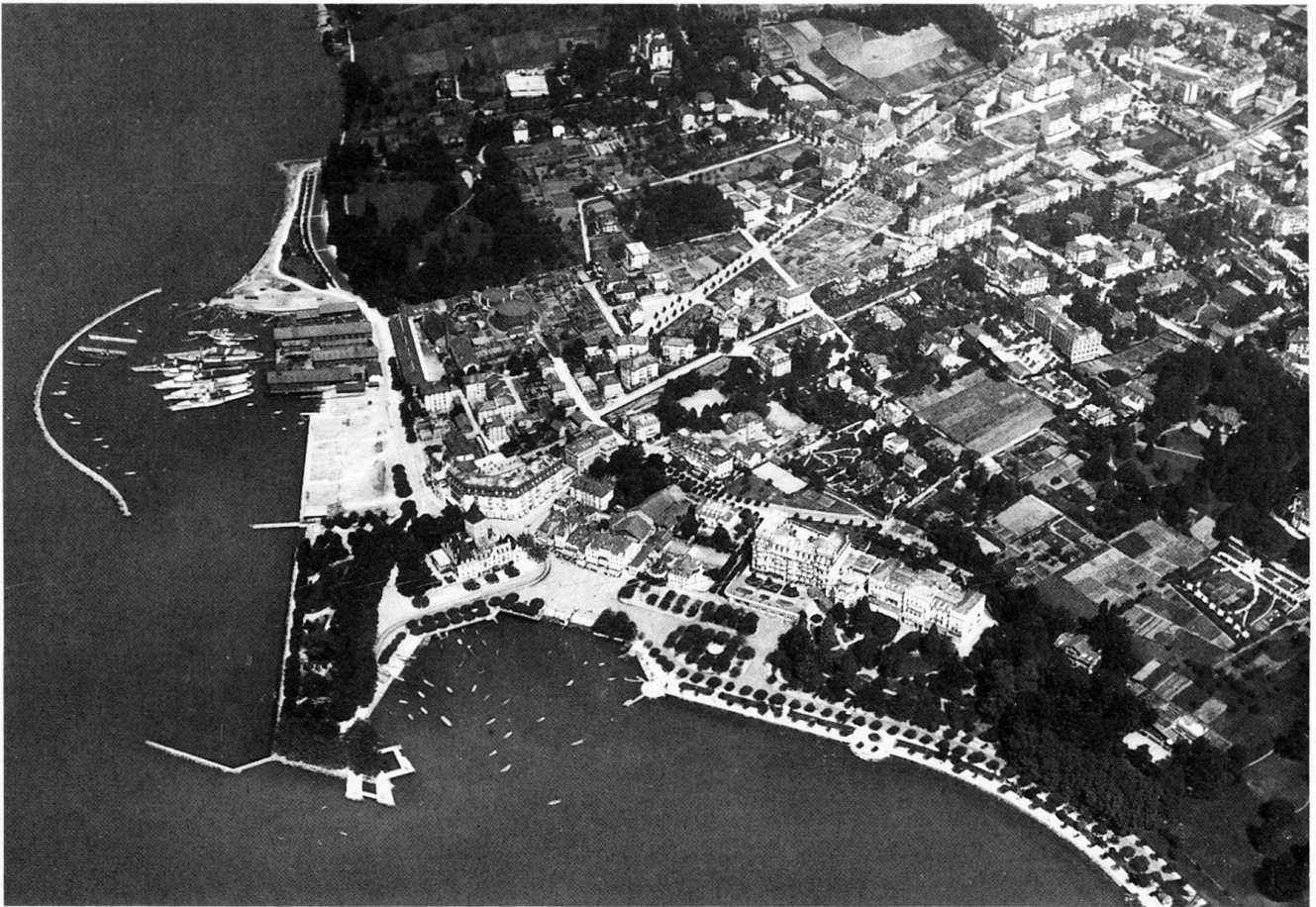
Fig. 77 Vue aérienne d'Ouchy et des quartiers sous-gare avant 1920 (2.6.16); le port marchand et les ateliers de la CGN, le jardin anglais, le grand quai et le Beau-Rivage Palace. Photographie Swissair.
