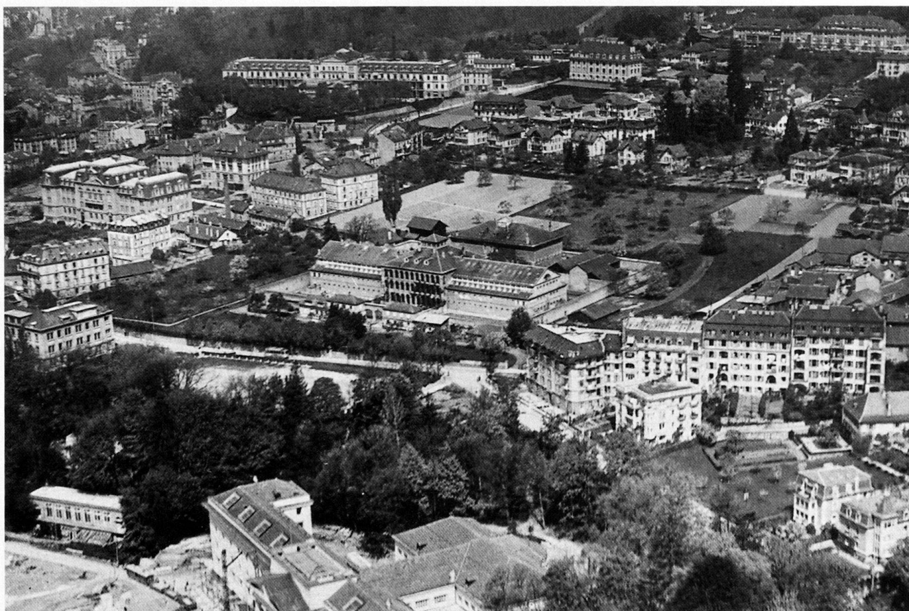
Fig. 73 Vue aérienne du secteur nord de la ville au moment de la construction du Tribunal fédéral de Mon-Repos; les Ecoles Normales, la «Maison de force», l'Hôpital cantonal (2.6.11). Photographie anonyme non datée.
