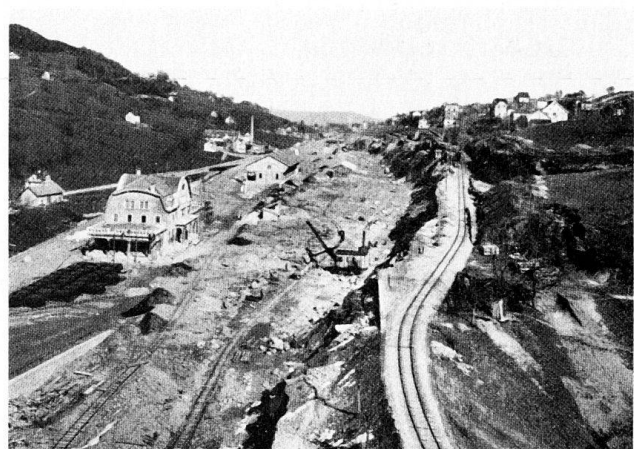
Abb. 5 Herisau. Terrainveränderungen 1907–1908 beim Bau der neuen Bahnhofanlage, in welche die bestehende, 1875 eröffnete Linie nach Winkeln (seit 1913 nach Gossau) und die 1907–1910 gebaute Bodensee–Toggenburg-Bahn eingeführt wurden. Foto aus Herisauer Schreibmappe 1909. Vgl. Abb. 6.
