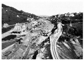
Abb. 5 Herisau. Terrainveränderungen 1907–1908 beim Bau der neuen Bahnhofanlage, in welche die bestehende, 1875 eröffnete Linie nach Winkeln (seit 1913 nach Gossau) und die 1907–1910 gebaute Bodensee–Toggenburg-Bahn eingeführt wurden. Foto aus *Herisauer Schreibmappe* 1909. Vgl. Abb. 6.
