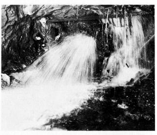
Abb. 5 Grenchen. Quellanbohrung 1912 beim Bau des Grenchenbergtunnels, welche die Neuanlage der Gemeinde-Wasserversorgung zur Folge hatte. Photo 1912. Vgl. Abb. 55, 56.
