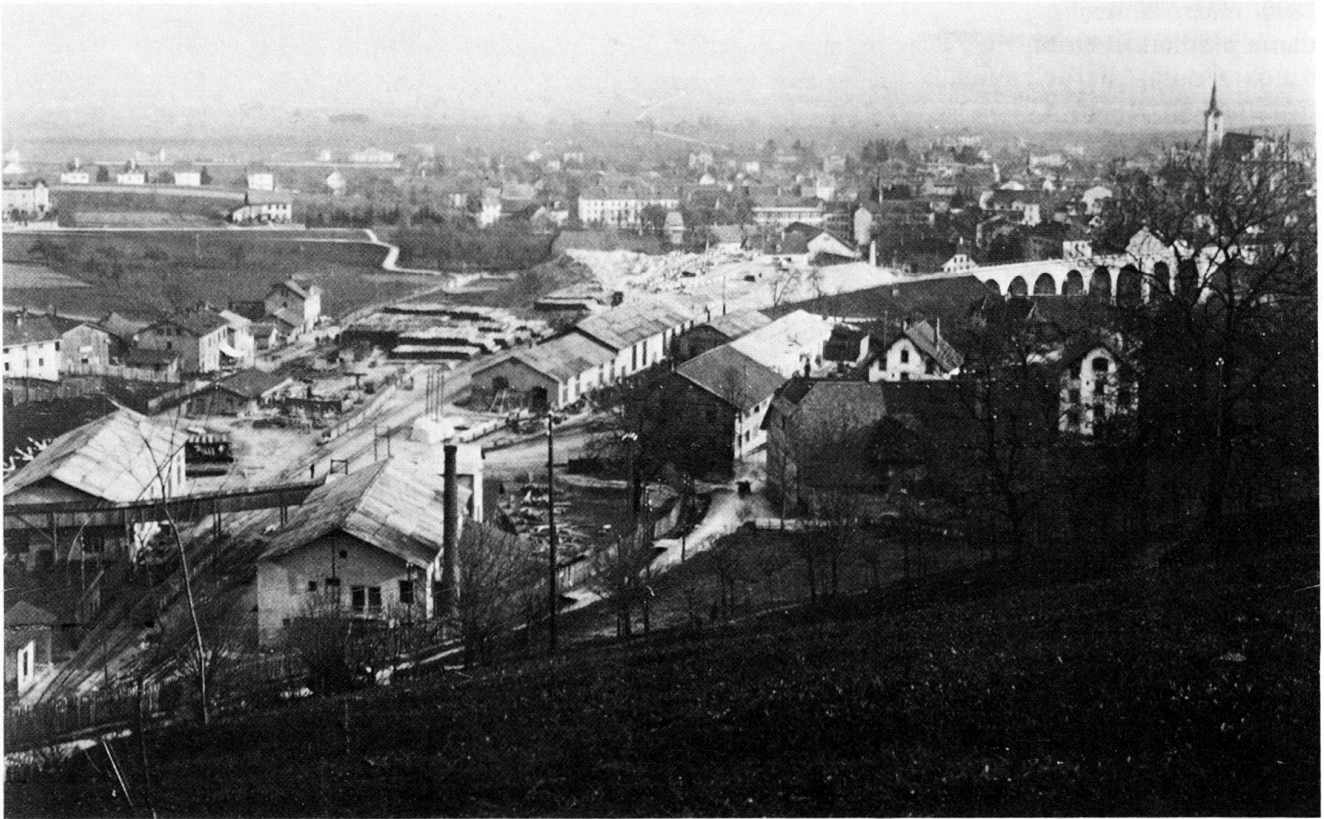
Abb. 4 Grenchen. Bauinstallation am Südportal des 1911–1915 erstellten Grenchenbergtunnels (Bahnlinie Lengnau–Grenchen-Münster). Links das Arbeiter-Barackendorf «Tripolis». Photo 1912.
