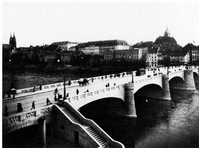
Abb. 49 Basel. Mittlere Rheinbrücke, neu erbaut 1903–1905. Betonkern, mit Granit verkleidet. Photo Wehrli A.G., Kilchberg-Zürich, um 1906.
