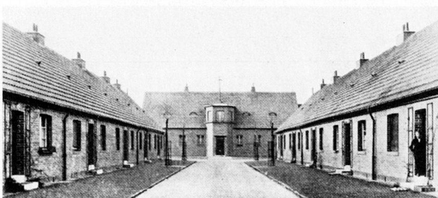
Abb. 91 Basel, Eugen Wullschlegler-Strasse. Siedlung im Vogensang, erb. 1925–1926 von Hans Bernoulli. Photo um 1930.
