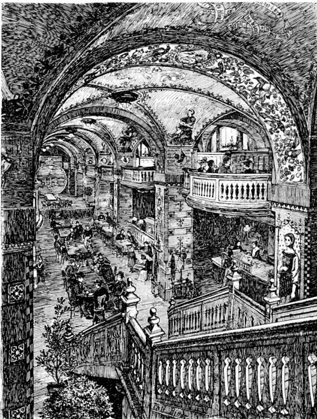
Abb. 66 Bern, Kornhauskeller nach der Umgestaltung von 1897–1898. Dekorationsmalereien von Rudolf Mürger mit volkstümlichen Motiven. Zeichnung von Philipp Ritter im Kornhauskeller-Büchlein , Bern 1899, S. 10.
