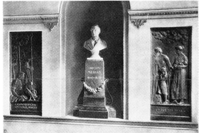
Abb. 19 Basel, Elisabethenstrasse Nr. 8, Ehem. Verwaltungs- gebäude der Christoph Merian Stiftung. Ehem. Denkmal für den Stifter, 1899 von Richard Kissling.
