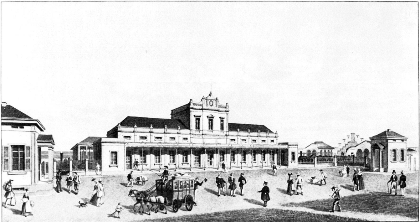
Abb. 4 Basel. Französischer Bahnhof (Linie Strassburg–Basel), erb. 1844–1846, in Betrieb bis 1860.
