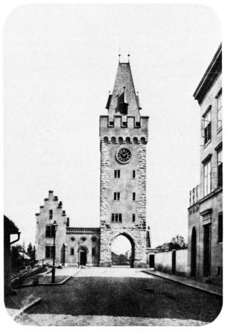
Abb. 7 Basel. St. Alban-Tor, 13./14. Jh.; Umbau 1871–1873 (Steildach, Zinnenkranz, Zugangstreppe, Wachthäuschen, Spritzenhäuschen). Photographie um 1875.
