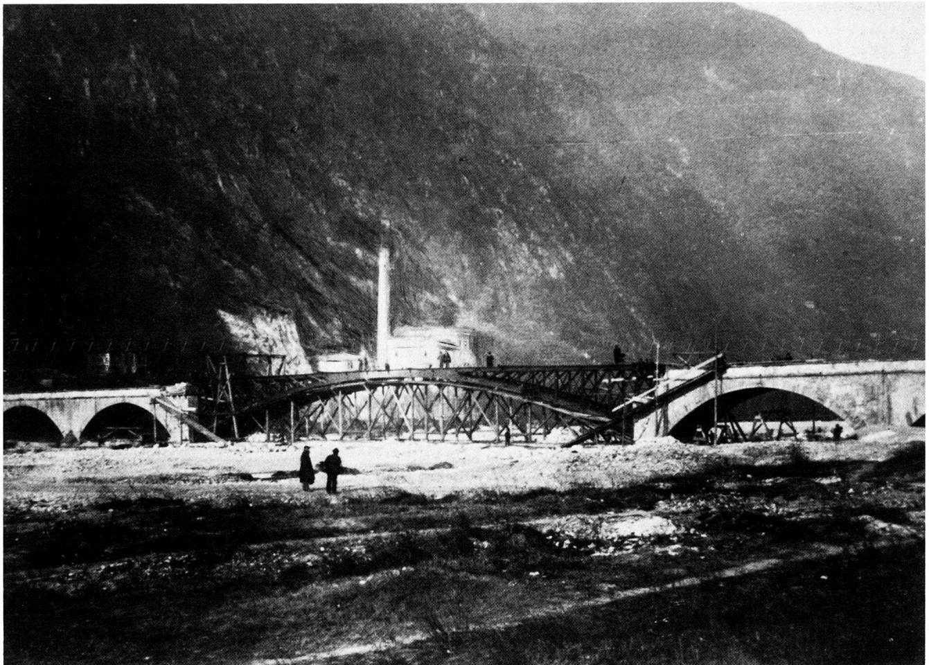
Ill. 30 Bellinzona, Ponte della Torretta, gettato negli anni 1813–1815. Durante i lavori di correzione del fiume Ticino le arcate centrali furono sostituite con un arco in ferro. Sullo sfondo, la ciminiera della Birreria Bonzanigo. Fotografia del 11.1.1901. Vedi ill. 15.
