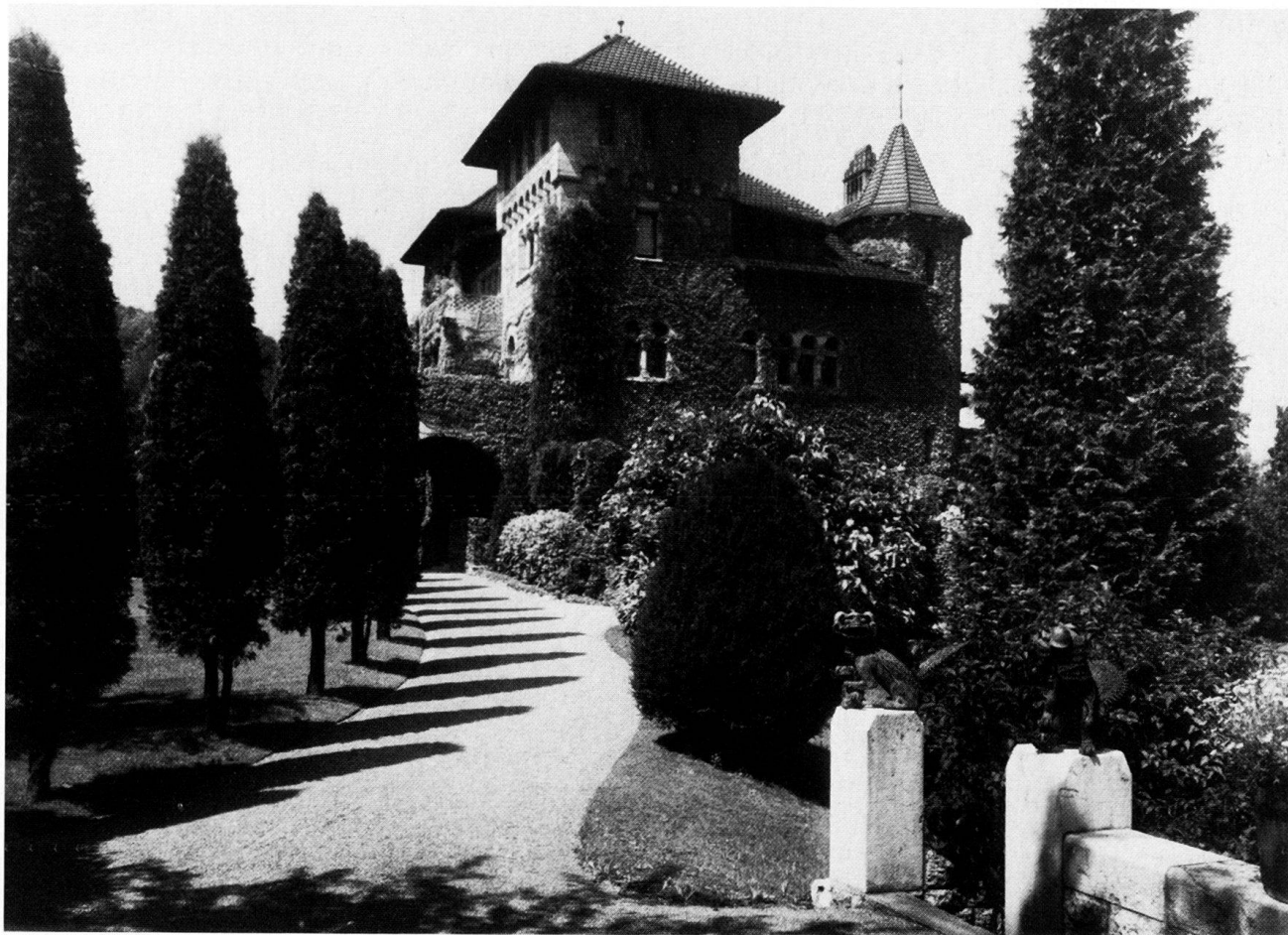
Abb. 51 Baden, Römerstrasse Nr. 36. Villa Römerburg, erbaut 1898–1899 von Curjel & Moser für Ingenieur und Firmengründer Charles Eugen Lancelot Brown. Abgebrochen 1957. Photo um 1915.
