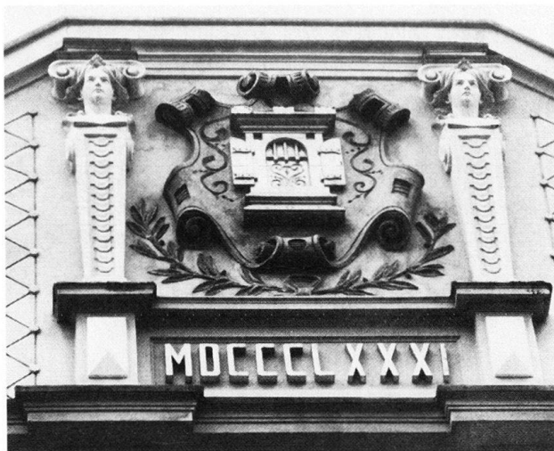
Abb. 12 Baden. Wappen der Hotelier- und Künstlerfamilie Dorer im Giebelfeld des Badehotels Bären, 1881, wohl von Bildhauer Robert Dorer. Photo Aargauische Denkmalpflege 1983.
