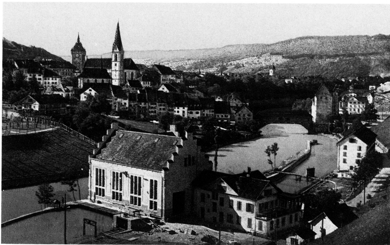
Abb. 53 Baden. Architektonischer Bezug auf die Altstadt. Der spätgotische Treppengiebelbau des Landvogteischlosses von 1487–1490 am rechtsufrigen Brückenkopf als Vorbild für das 1907 von Dorer & Fuchsli erbaute Maschinenhaus des Elektrizitätswerkes Aue (im Vordergrund).
