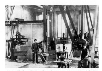
Abb. 6 Baden, Fabrikanlage der Firma Brown Boveri & Cie. Erste Werkstattaufnahme im Frühling 1892. Ein Dampflokomobil von 12,5 PS (im Hintergrund) trieb die ersten drei Transmissionsstränge an. Damit wurde auch ein Licht- und Kraftdynamo vom Manchestertyp (System C.E.L. Brown) in Betrieb gesetzt, der den Lichtstrom lieferte. Links Ingenieur W. Baerlocher am Schalter, rechts Betriebsleiter Leutenegger.
