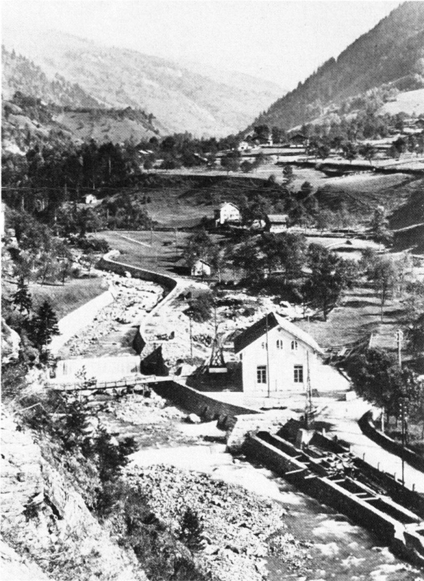
Abb. 18 Altdorf. Elektrizitätswerk in Hartolfingen bei Bürglen, erbaut 1895–1896. Die Energie lieferte der 1910–1912 verbaute Schächenbach. Photographie von Michael Aschwanden, um 1912.
