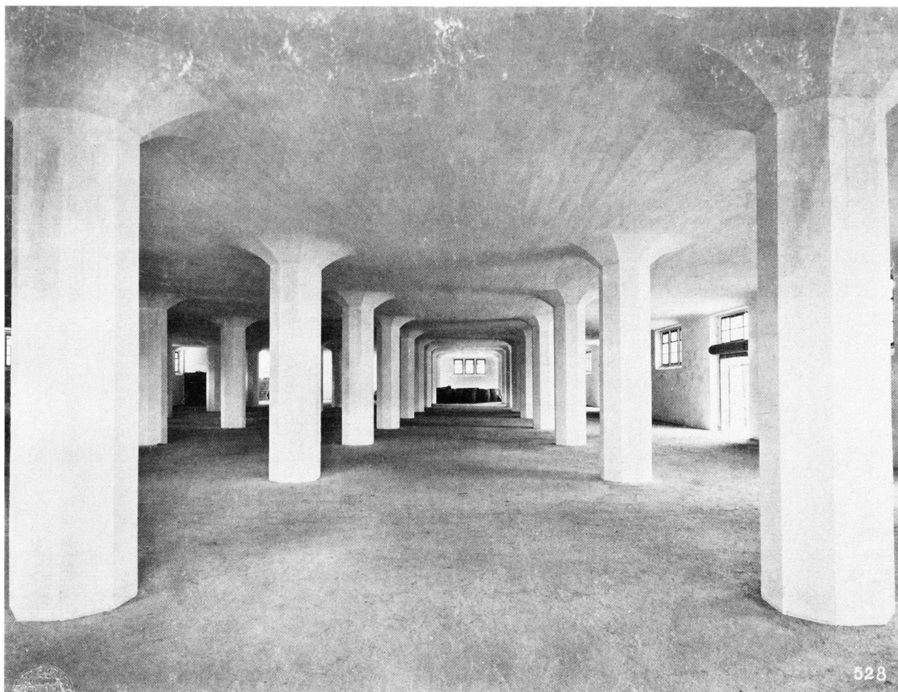
Abb. 51 Altdorf. Sacklagergebäude der Eidg. Getreidemagazine, erbaut 1912–1913 vom Ingenieurbüro Robert Maillart & Cie (Zürich und St. Gallen). Pilzdeckenkonstruktion des Erdgeschosses. Photographie um 1913 (vgl. Abb. 50, 58, 59).
