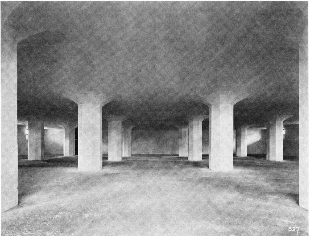
Abb. 50 Altdorf. Sacklagergebäude der Eidg. Getreidemagazine, erbaut 1912–1913 vom Ingenieurbüro Robert Maillart & Cie (Zürich und St. Gallen). Pilzdeckenkonstruktion des Kellergeschosses. Photographie um 1913 (vgl. Abb. 51, 58, 59).
