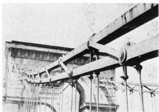
Abb. 20 und 21 Aarau. Detailplan zum Projekt einer Kettenbrücke über die Aare, 1848 von Ingenieur Richard La Nicca in Chur. Staatsarchiv Chur, Plansammlung. – Detailaufnahme der 1848–1850 von Jean Gaspard Dollfus erbauten Kettenbrükke, an der das gleiche System im Dreiecksverband verwendet wurde.
