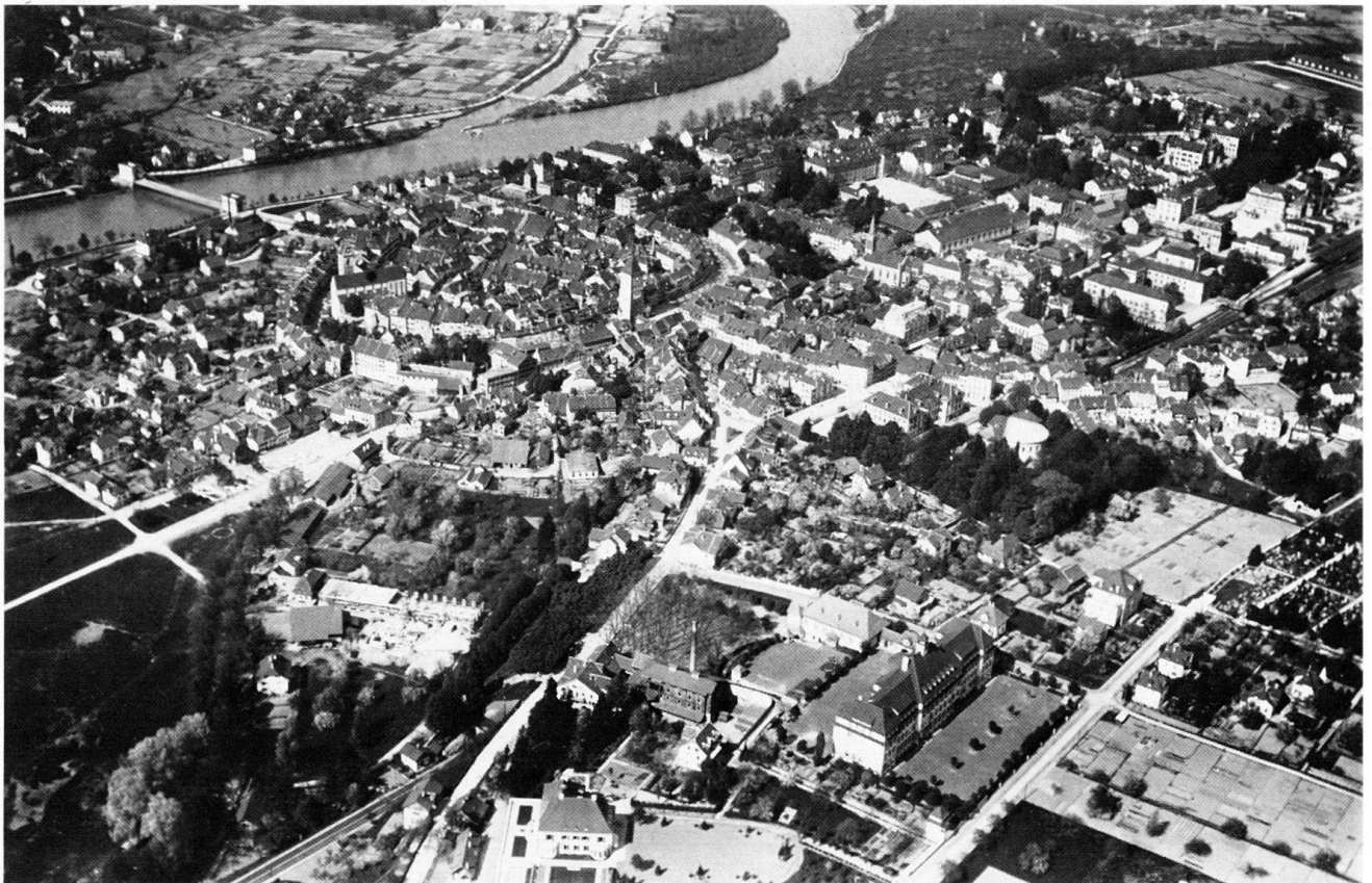
Abb. 30 Aarau gegen Nordosten. Im Vordergrund Bahnlinie von Olten, Schönenwerderstrasse–Rain und Zelglischulhaus, am Rand des Schachenareals links die im Bau befindliche Neuanlage der feinmechanischen Werkstätte Kern & Cie. Flugaufnahme von Walter Mittelholzer (Zürich), 1920.
