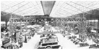
Fig. 90 et 91 La Halle des macnines. Echataudage roulant ayant servi au montage successif des deux moitiés de la halle. Vue générale de l'intérieur, prise du haut du Bâtiment des turbines (cf. Fig. 6).
