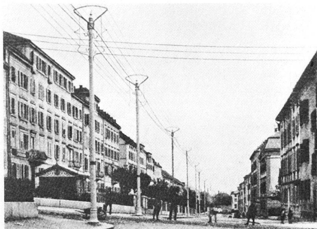
Fig. 29 La Chaux-de-Fonds. Conduite électrique aux Endroits . Photographie de 1897. Ligne de haute tension à courant continu et ligne de basse tension s'accrochent au même pylône.
