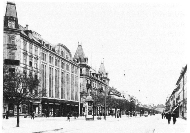
Fig. 30 La Chaux-de-Fonds. Avenue Léopold-Robert, nos 48–54, photographie vers 1910. Au premier plan à gauche, l'ancien Hôtel Central, puis le grand magasin Grosch & Greiff, façade verticaliste dessinée par Otto Engler, architecte à Düsseldorf, puis la Banque fédérale S.A.
