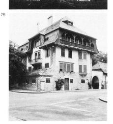
cadrements de simili. Ondulation et déhanchement des combles. Plus amusant que maîtrisé. Planchers de béton armé, système Hennebique. PF 1910, 16.
