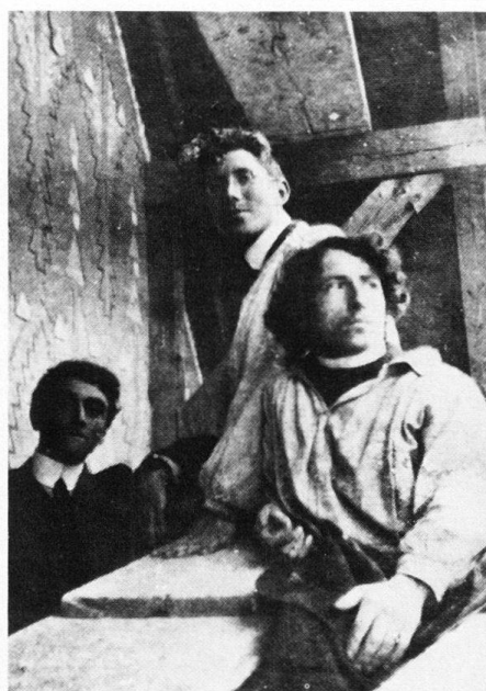
Fig. 15 Le chantier de la villa Fallet (voir Fig. 36), vraisemblablement en 1906. Le trio André-Jean Evard, Charles-Edouard Jeanneret, Léon Perrin (de gauche à droite).
