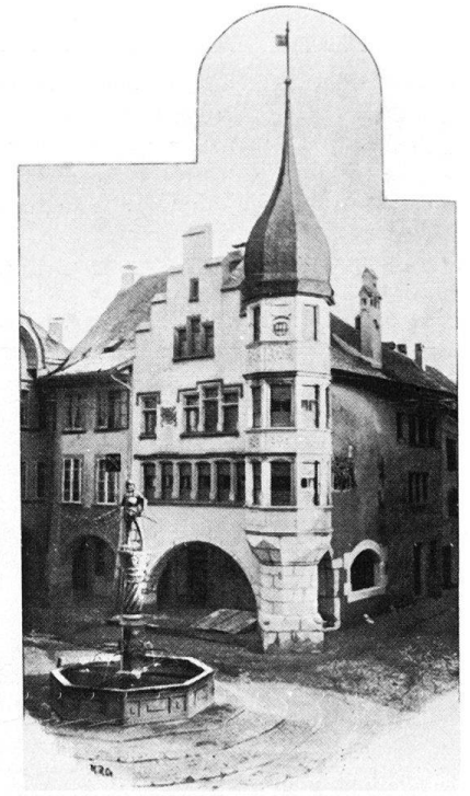
Abb. 24 Biel, Ring. Ehemaliges Zunfthaus zu Waldleuten, erbaut 1561. Restaurierung und Rekonstruktion 1900 von E. J. Propper. Photographie aus dem Werk Das alte Biel (vgl. Abb. 22).
