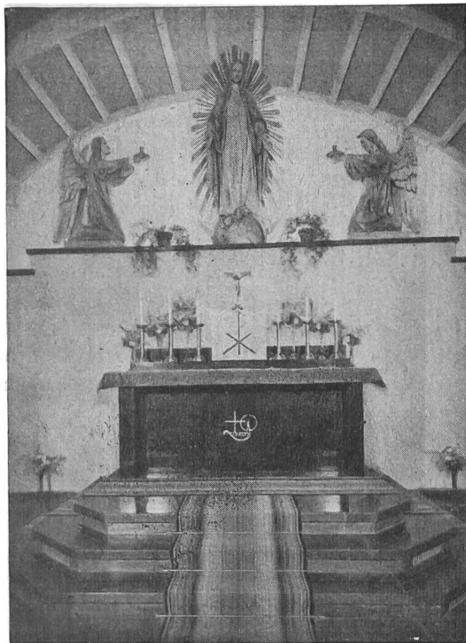
Chor der neuen Pfarrkirche von Oberstammheim
