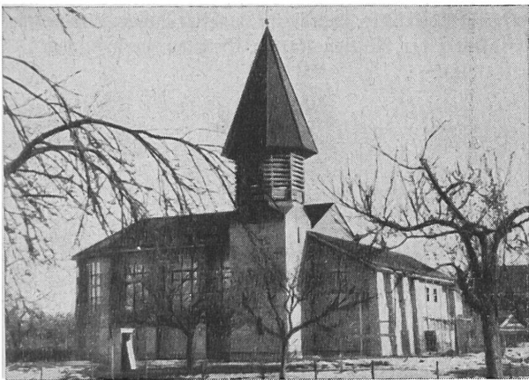
Die neue Kirche von Heerbrugg im Koblenz
