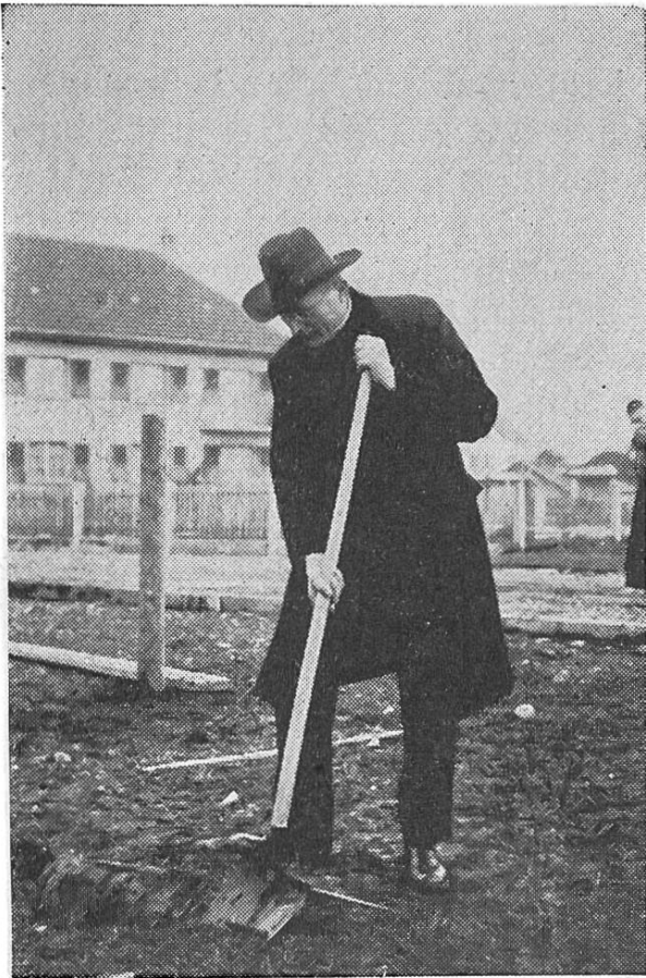
Hochw. Herr Pfarrer Simonett beim Spatenstich in Ostermündigen.
