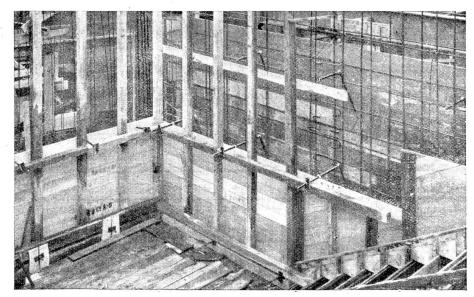
Fig. 2. Schalwand mittels Dübelschraube (Eidg. technische Hochschule)
