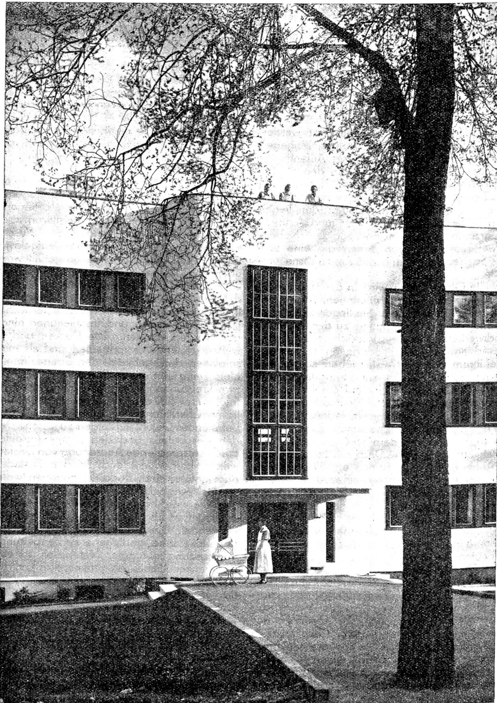
Haupteingang (auf der Nordseite)
