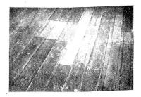
Abb. 14. Reparierter Fußbodenbelag.
