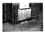
Abb. 13. Fruchtkörper bei neu ersetztem Holzwerk.
