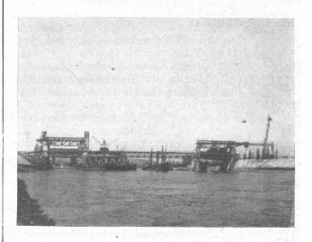
Abbildung 5. Wehranlage im Febr. 1932. Nach Inbetriebnahme d. Schleusen und des Kanals werden noch die mittleren Pfeiler aufgeführt.
