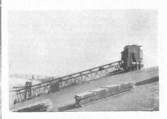
Abbildung 1. Betonierungseinrichtung der Dinglerschen Maschinenfabrik, für die Betonierung der Böschungen.
