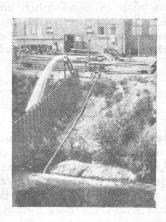
Die Maschinen sind auch vorzüglich zum Füllen und Entleeren von Wasserwagen, die bei Straßenbauten Verwendung finden, geeignet. Die Wagen brauchen nicht mehr bis zur Stadt zurückzufahren, um durch Hydranten gefüllt zu werden, sondern jeder leicht erreichbare Teich oder Wassertümpel kann zum Auffüllen der Tankwagen herangezogen werden.
