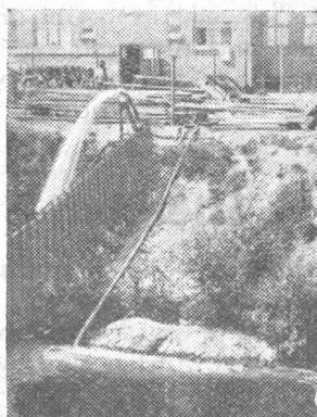
Die Maschinen sind auch vorzüglich zum Füllen und Entleeren von Wasserwagen, die bei Straßenbauten Verwendung finden, geeignet. Die Wagen brauchen nicht mehr bis zur Stadt zurückzufahren, um durch Hydranten gefüllt zu werden, sondern jeder leicht erreichbare Teich oder Wassertümpel kann zum Auffüllen der Tankwagen herangezogen werden.
