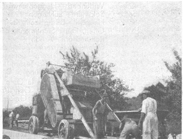
Abbildung Nr. 1. Anfuhr der Kies-Sandmischung und des Zementes zur Baustelle, mit Rollwagen; Hochziehen auf die Betonmischmaschine.
