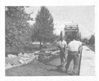
Abbildung Nr. 2. Betonmischmaschine, Selbstfahrer, mit Schwenkarm und Förderband; Verteilung der Mischung des Unterbetons über die Eiseneinlagen. Rechts eine Fahrbahnhälfte fertig betoniert.
