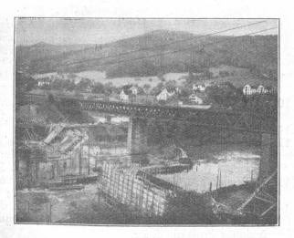
Abbildung 1. Blick vom rechtsseitigen Limmatufer auf die Baustelle. Links Wehrbau, rechts Krafthausbau. In der Mitte Durchfluß der Limmat. Brücke der Schweizerischen Bundesbahnen.
