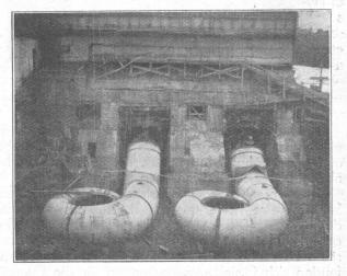
Abbildung 2. Krafthaus, Südseite. Wasserzuführungskanal zu den Turbinen.
