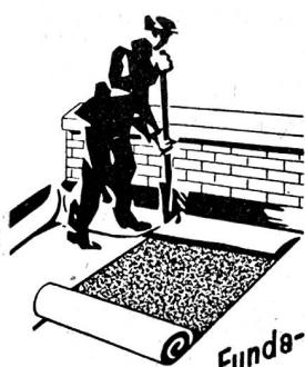
Zum Isolieren von Fundamenten, zum Abdichten von Tunnels, Gewölben, Veranden Bassins, sowie für Flachbedachungen, den elastischen Asphalt-Isolierstoff.
