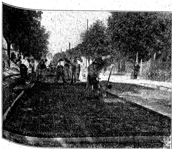
Abbildung 2. Neue Betonstraße Arbon. Eisengeflecht im Unterbeton.
