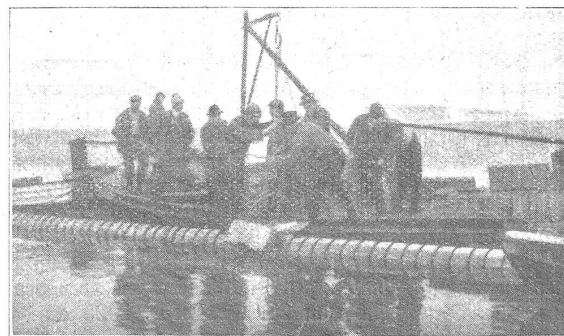
Abb. 15. Auflegen der Betonbelastung (24. Dezember 1924).
